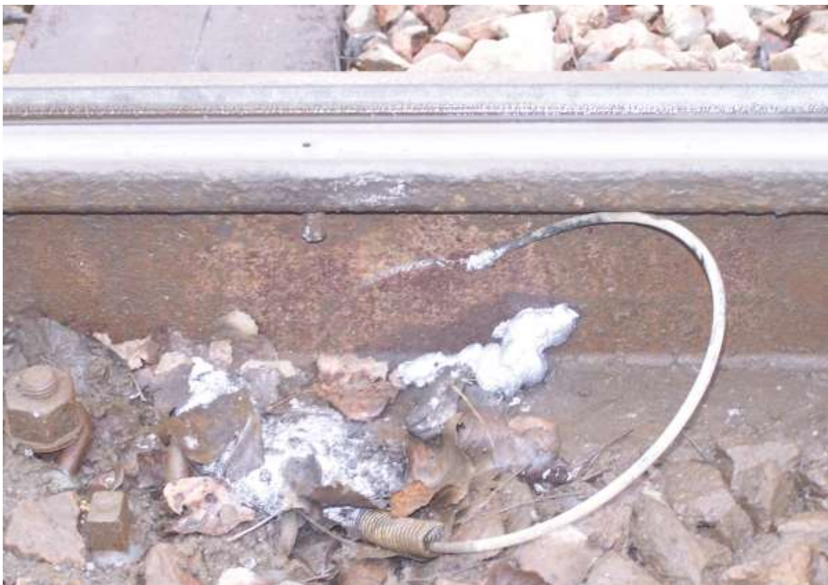
Rys. 11.2.5. Zerwany przewód doprowadzający – wypływ smaru poza główkę szyny
