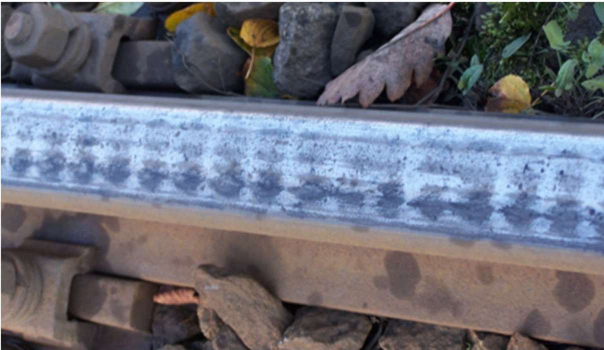
Rys. 11.2.1. Falistość na główce szyny
