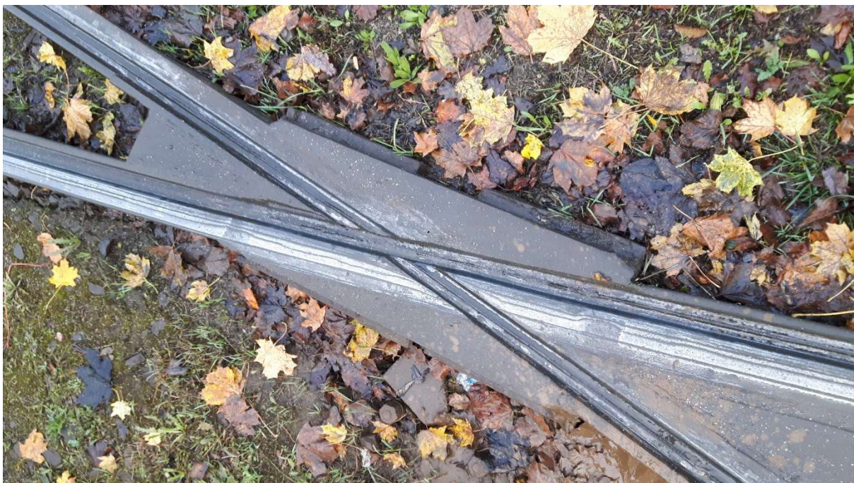
Rys. 8.2.4. Asymetryczne zużycie rowka w krzyżownicy płytkorowkowej eksploatowanej asymetrycznie
