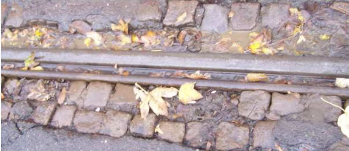
Rys. 11.2.3. Przykład zanieczyszczenia rowka szyny
