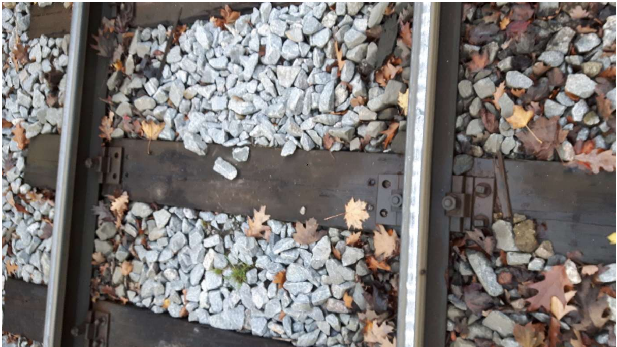
Rys. 8.4.2. Brak wkrętów w przytwierdzeniu typu K
