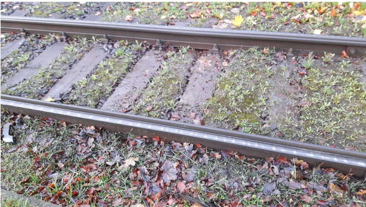
Rys. 8.5.2. Wychłapka w zaawansowanym stadium
