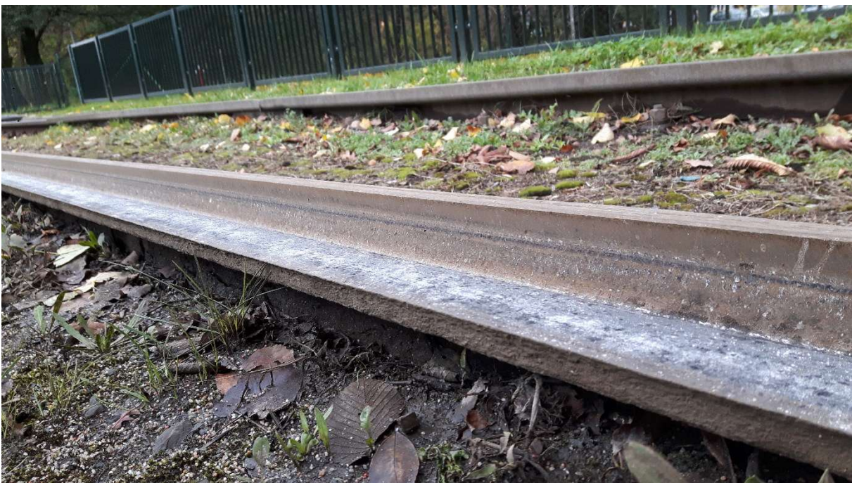
Rys. 8.2.2. Przykład zużycia pionowego szyny
