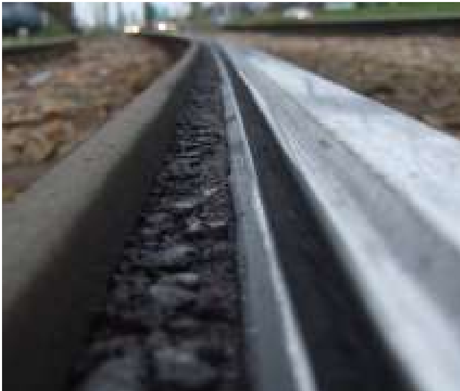
Rys. 11.2.2. Przykład zanieczyszczenia rowka szyny
