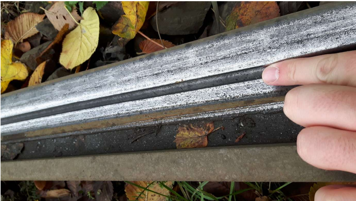
Rys. 8.2.1. Przykład zużycia bocznego główki szyny
