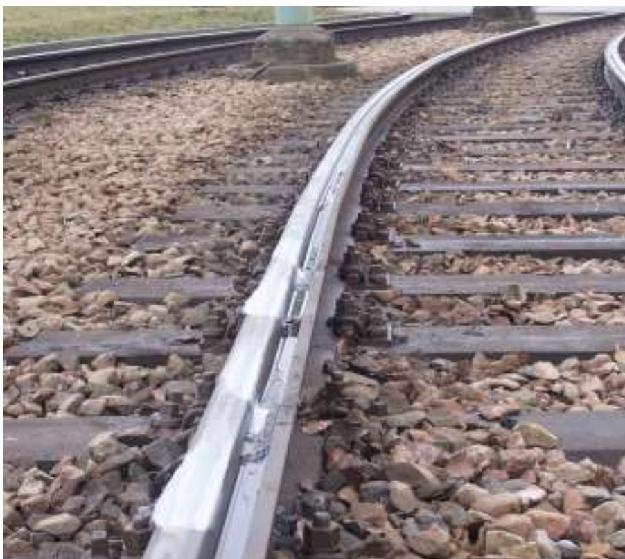
Rys. 11.2.6. Źle rozprowadzany smar na szynie
