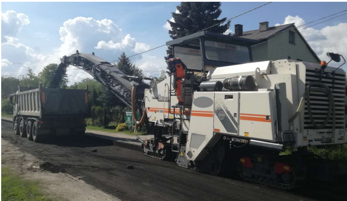
Rys. 4.6.2.1. Przykład frezowania nawierzchni na całej powierzchni
