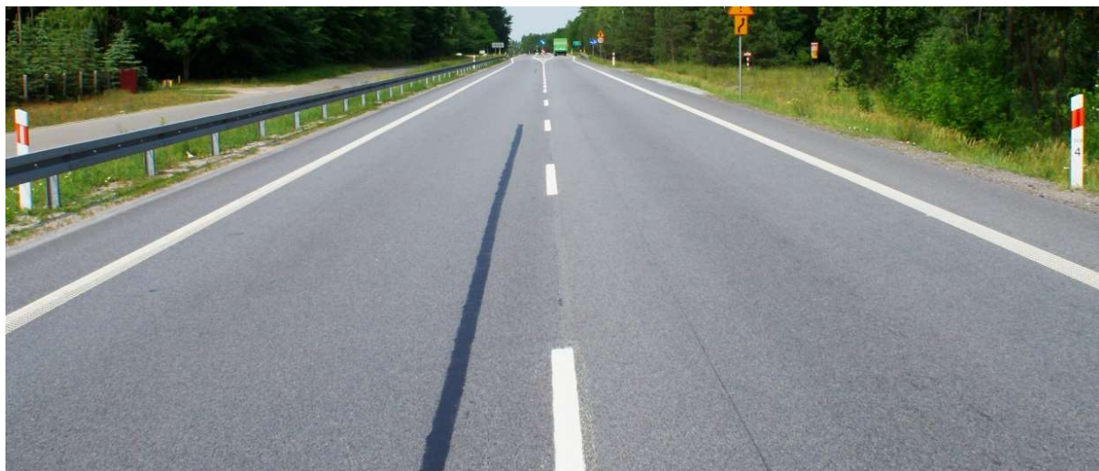
Rys. 4.8.1.2. Przykład wypełnienia pęknięcia metodą pasmową bez rozfrezowania
