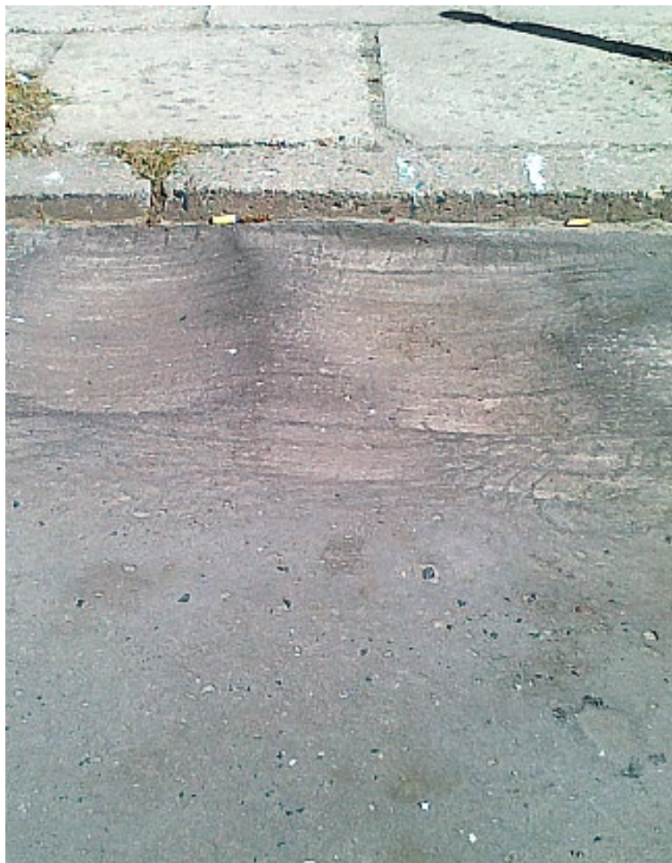
Rys. 5.1.1.3. Deformacje trwałe – odciski
