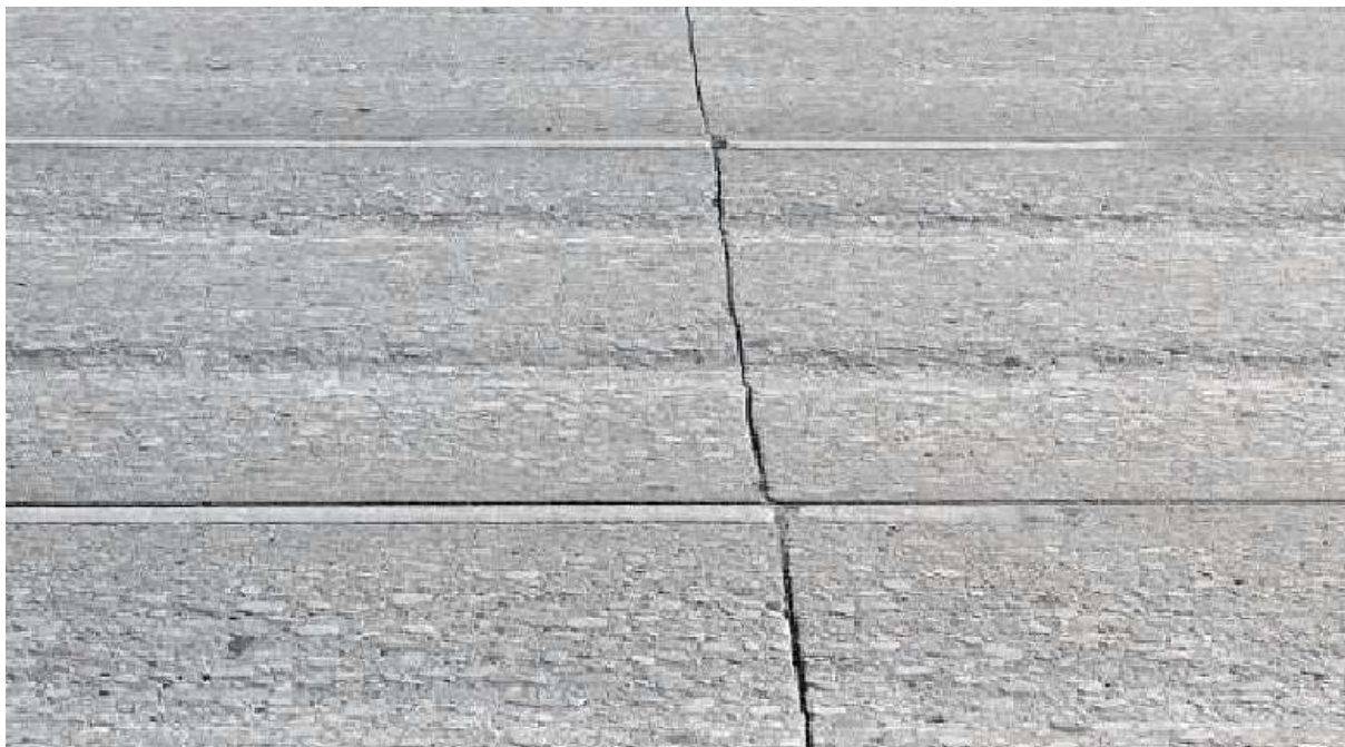
Rys. 5.2.1.1. Widok poprzecznych deformacji trwałych
