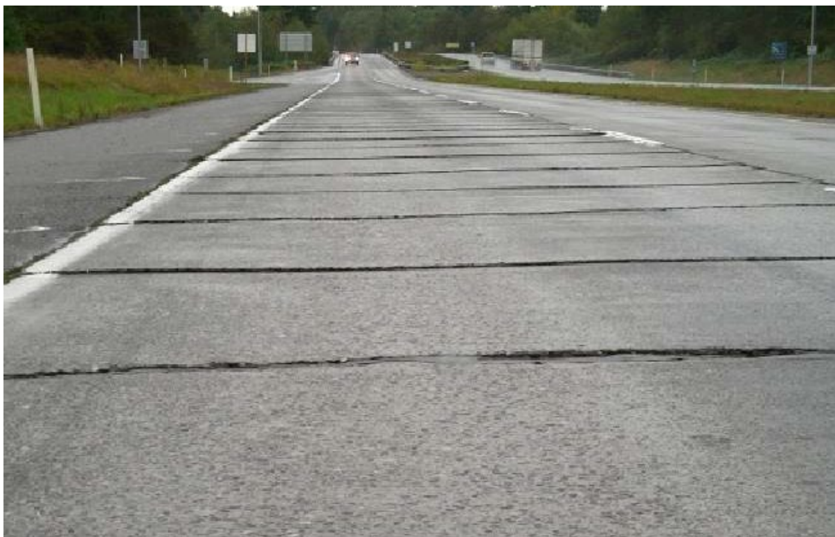
Rys. 5.2.1.6. Widok uskoków płyt
