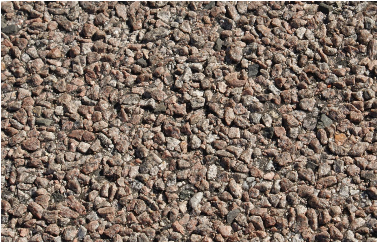
Rys. 4.3.1. Przykład powierzchniowego utrwalenia [fot. Jan Król]
