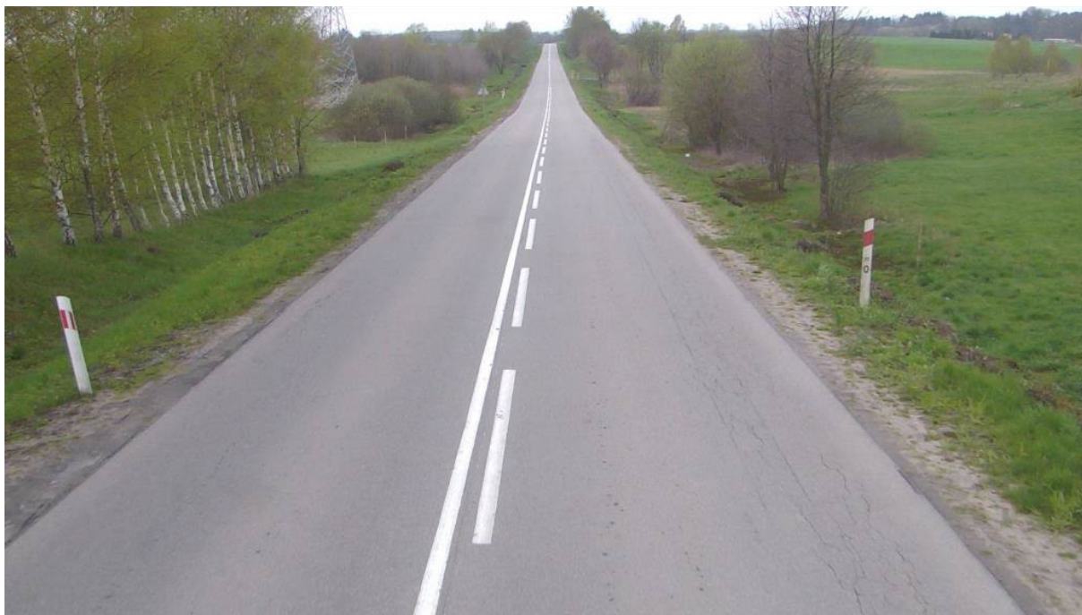
Rys. 5.1.2.2. Stan niezadawalający: skupiska spękań siatkowych zajmujące do 15% powierzchni [6]
