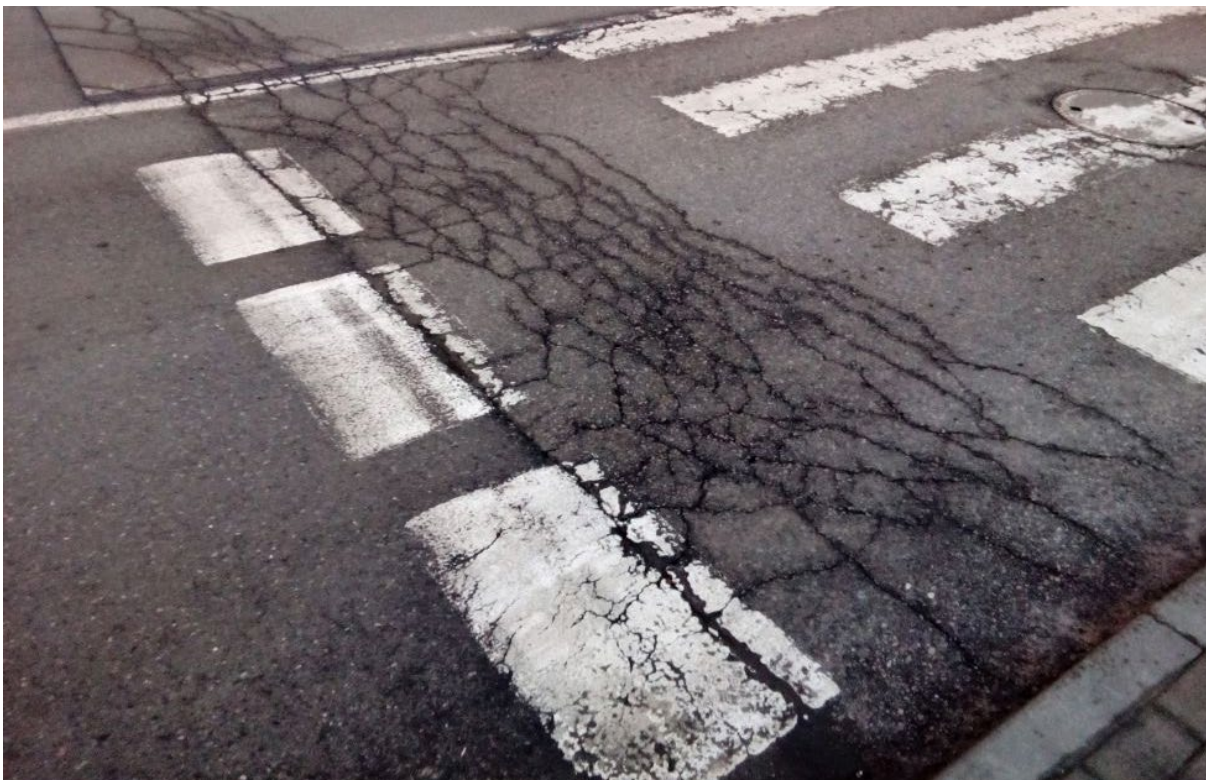
Rys. 5.1.2.5. Przykład spękania zmęczeniowego przy połączeniu technologicznym
