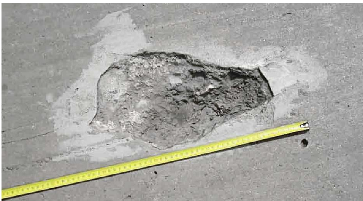
Rys. 5.2.3.8. Widok wyboju
