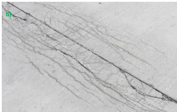
Rys. 5.2.3.2. Widok pęknięć mrozowych: a) w postaci nieregularnej siatki; b) przy krawędzi płyty
