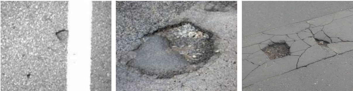
Rys. 5.1.3.3. Przykłady wybojów [6]
