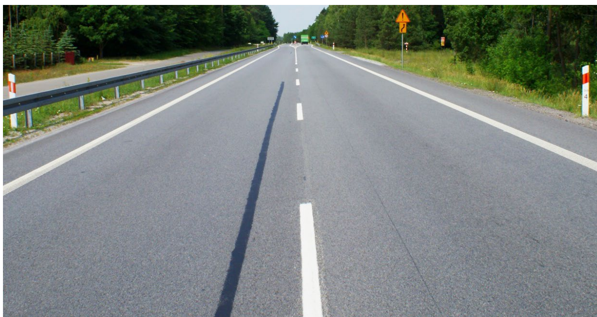
Rys. 4.8.1.2. Przykład wypełnienia pęknięcia metodą pasmową bez rozfrezowania [fot. Jan Król]
