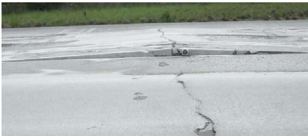
Rys. 5.2.1.4. Widok deformacji podłużnych na długości płyty
