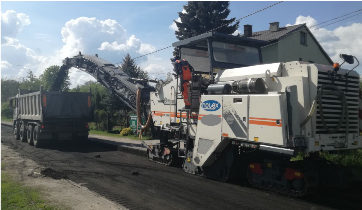
Rys. 4.6.2.1. Przykład frezowania nawierzchni na całej powierzchni [fot. Jan Król]
