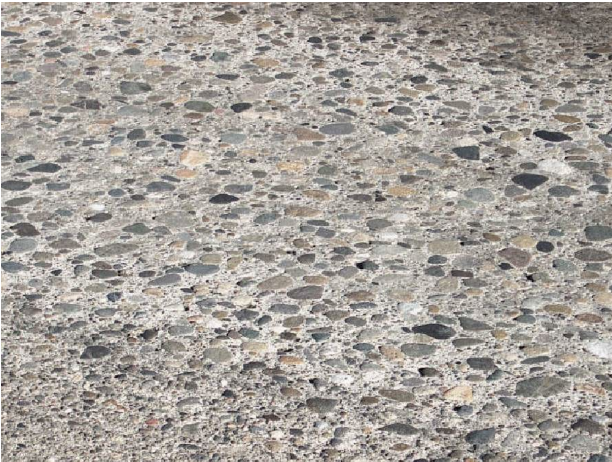
Rys. 5.2.3.1. Widok wypolerowanej powierzchni płyty
