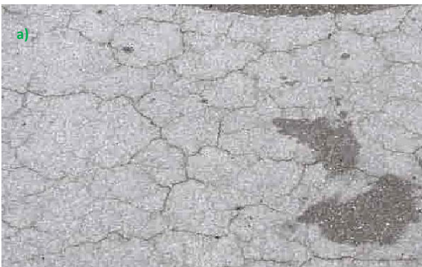
Rys. 5.2.3.2. Widok pęknięć mrozowych: a) w postaci nieregularnej siatki; b) przy krawędzi płyty
