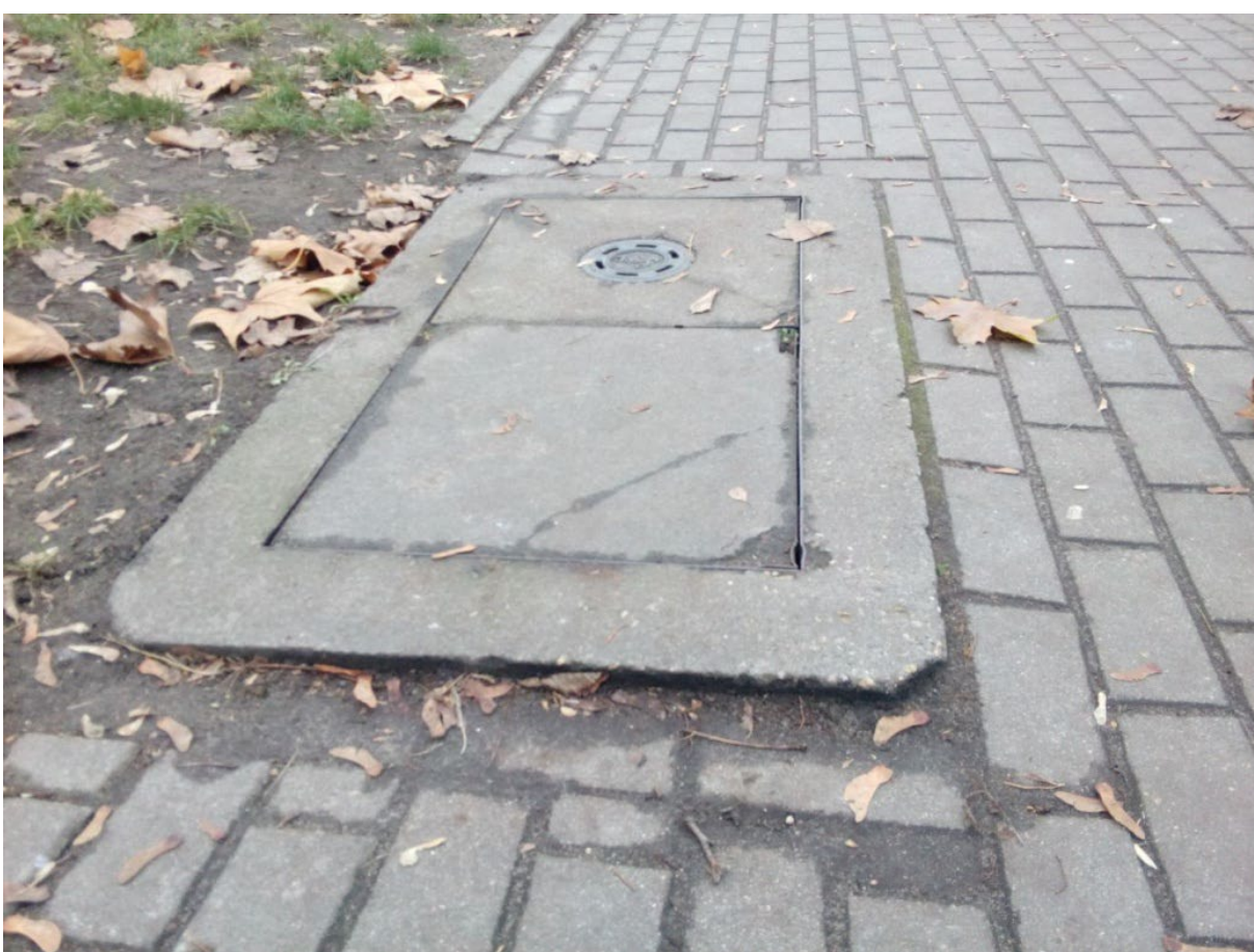
Rys. 6.8. Wyniesione urządzenia obce
