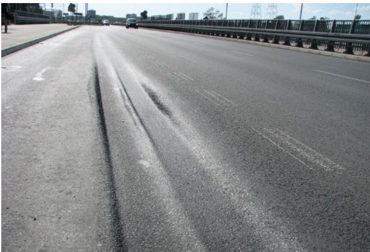
Rys. 5.1.1.1. Nierówności poprzeczne lepkoplastyczne
