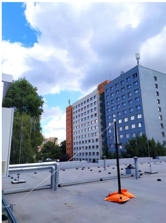
Rys. 2 Miejsce montażu pilotażowego SMS PEM – dach PP nr 50 w Szczecinie – widok na anteny SBTk
