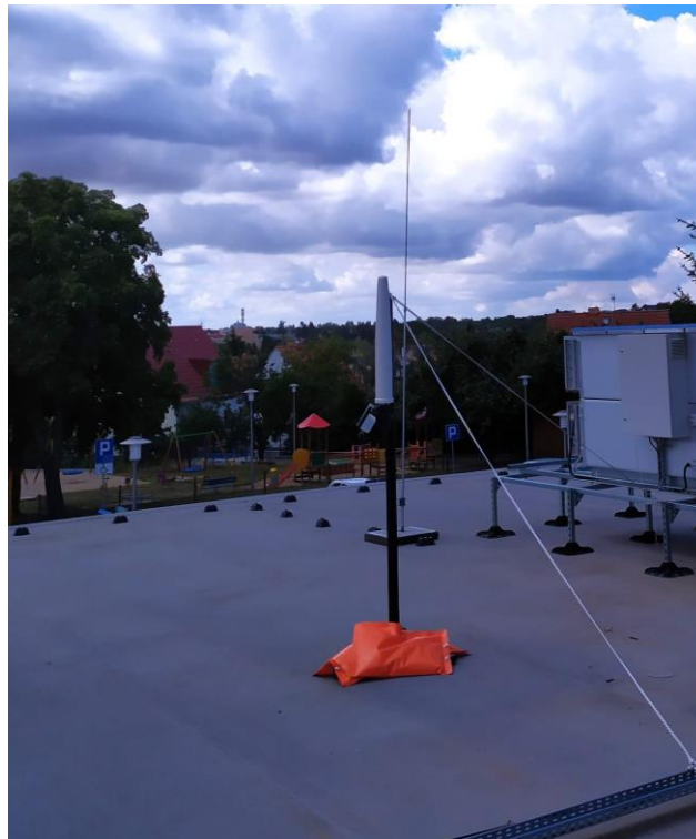
Rys. 4 Miejsce montażu pilotażowego SMS PEM – dach PP nr 50 w Szczecinie
