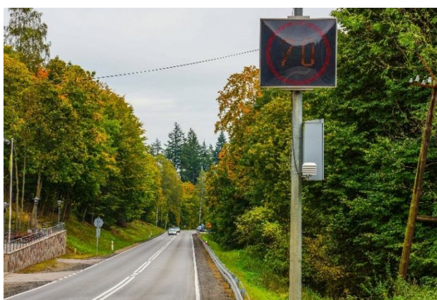
Rys. 3.18. Znaki zmiennej treści informujące o konieczności redukcji prędkości przed miejscem niebezpiecznym. Źródło: fot. własna.
