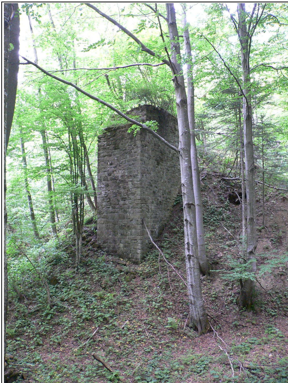
Fot. 5 Filar mostu kolejki (oddz. 21a).
