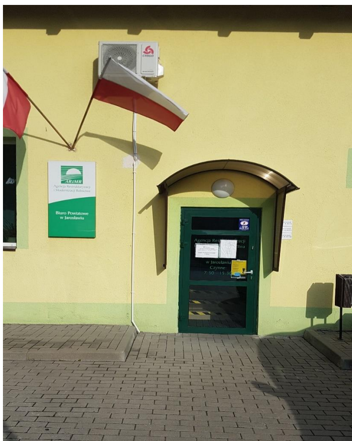
Fot.2 Wejście od strony parkingu do Biura Obsługi Klienta
