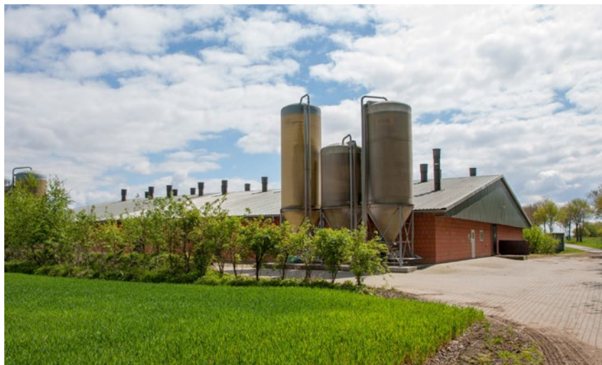
Refundacji w ramach inwestycji w obszarze rozwoju produkcji prosiąt podlegają m.in. koszty budowy, przebudowy, remontu połączonego z modernizacją budynków lub budowli wykorzystywanych do produkcji rolnej
