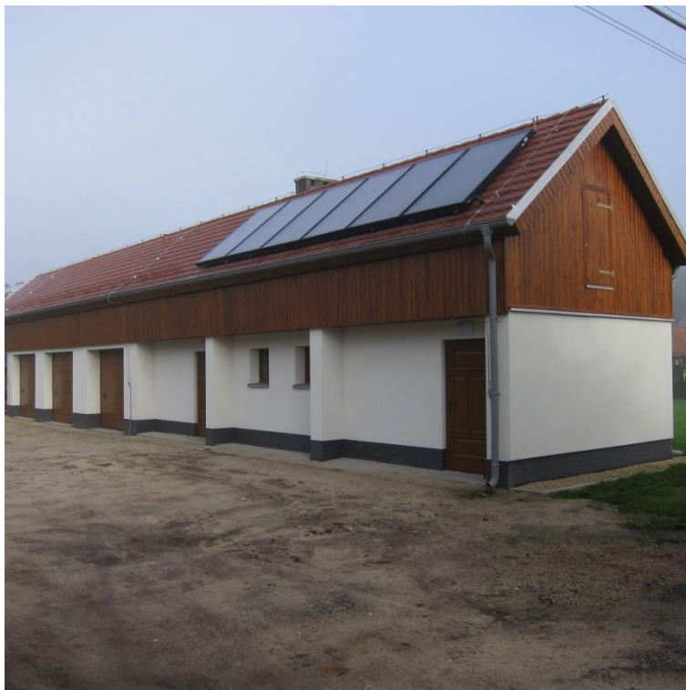
Fot. nr 3. Budynek gospodarczy, w którym znajdują się: kancelaria Leśnictw Łowieckich i garaże (przy Kwaterze Myśliwskiej w Niezgodzie , rok 2013.).
