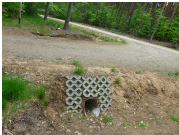
Zabezpieczenie nowo wybudowanej drogi / Leśnictwo Łąki (fot. autor)
