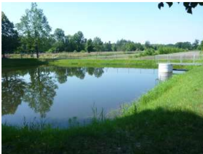
Zbiornik p. poż. na szkółce leśnej, Leśnictwo Borek (fot. autor)
