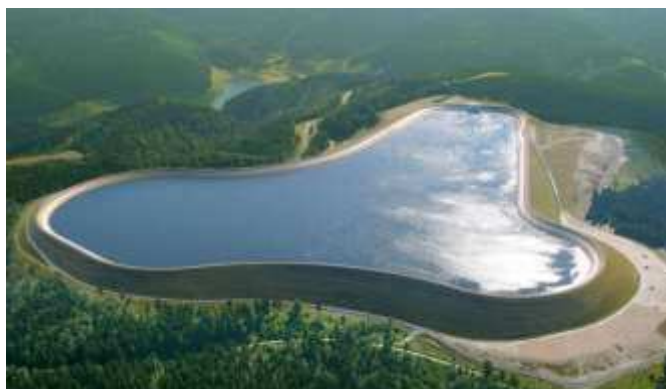
Rys. 2. Zbiornik górny w obwałowaniach sztucznych – ESP Goldisthal w Niemczech
