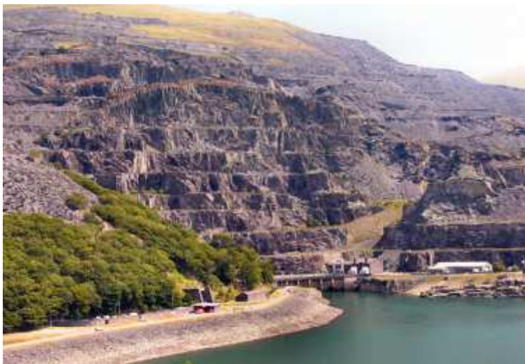
Rys. 10. Elektrownia szczytowo-pompowa Dinorwig w Walii.
