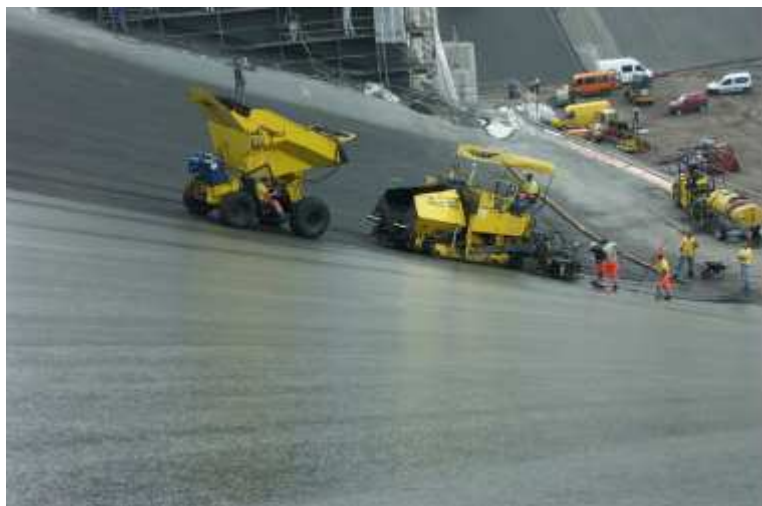
Rys. 3. Wykonanie renowacji ekranu asfaltobetonowego ESP Żarnowiec.
