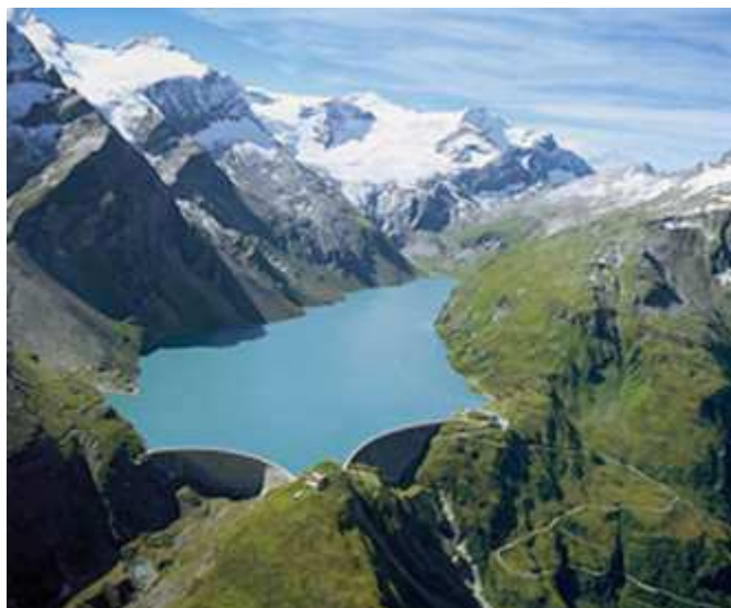
Rys. 1. Zbiornik górny ESP Limberg II w Austrii podparty dwoma zaparami łukowymi.
