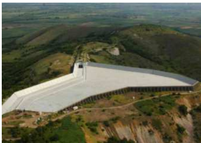
Rys. 4. Wykonanie ekranu szczelnego w technologii membranowej w ESP Aleko w Bułgarii.
