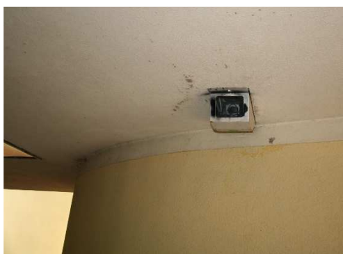
Rys. 3.105. Kamera monitorująca ruch w przejściu podziemnym bez uszkodzeń, widoczne jedynie zanieczyszczenia obudowy
