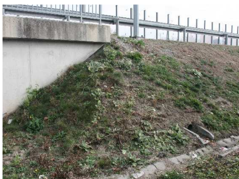
Rys. 5.45. Odwodnienie konstrukcji oporowej bez uszkodzeń, jedynie niewielkie zanieczyszczenia elementów odwodnienia
