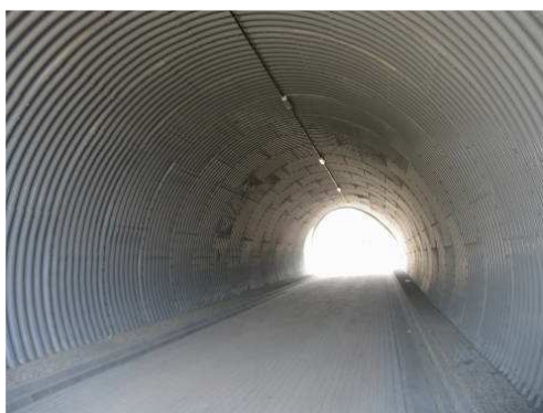
Rys. 3.10. Nawierzchnia jezdni bez uszkodzeń
