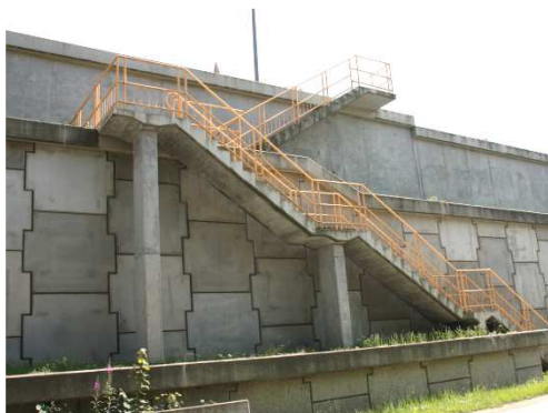
Rys. 5.56. Schody przy konstrukcji oporowej bez uszkodzeń
