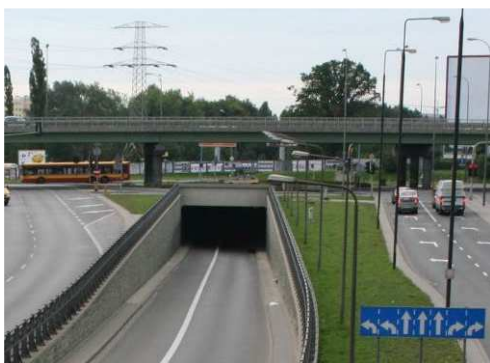
Rys. 3.89. Teren nad tunelem bez uszkodzeń mających wpływ na trwałość i bezpieczeństwo konstrukcji
