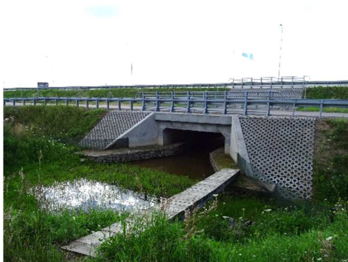
Rys. 4.93. Przepust ramowy zintegrowany z przejściem dla małych zwierząt z półkami z blachy stalowej i drewnianym pomostem bez uszkodzeń
