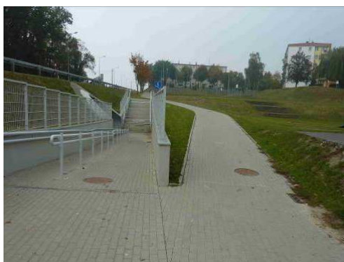
Rys. 3.23. Balustrady bez uszkodzeń
