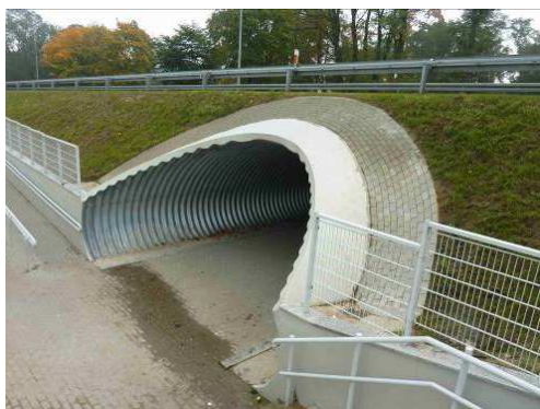
Rys. 3.6. Skarpa zasypki przejścia podziemnego wraz z umocnieniem bez uszkodzeń
