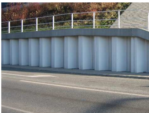
Rys. 5.39. Konstrukcja oporowa bez uszkodzeń
