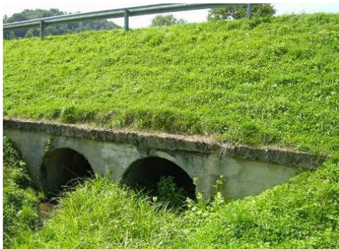
Rys. 4.1. Wegetacja roślinna na skarpie prawidłowo utrzymana
