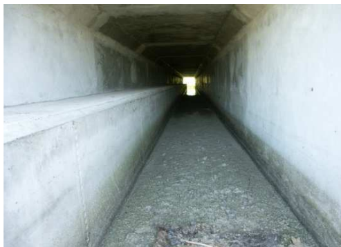
Rys. 4.89. Przepust skrzynkowy zintegrowany z przejściem dla małych zwierząt z półką betonową bez uszkodzeń
