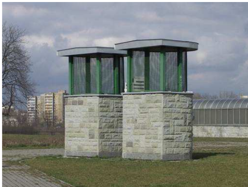
Rys. 3.47. Wyloty komór wentylacyjnych w dobrym stanie technicznym, odpowiednio utrzymane
