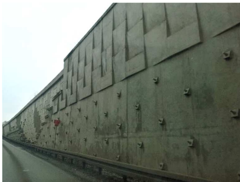
Rys. 5.59. Zakotwienia kotew gruntowych bez zastrzeżeń
