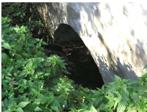
Rys. 4.80. Wegetacja roślin zmniejszająca przekrój koryta ciek. Roślinność blokuje przepływ wody
