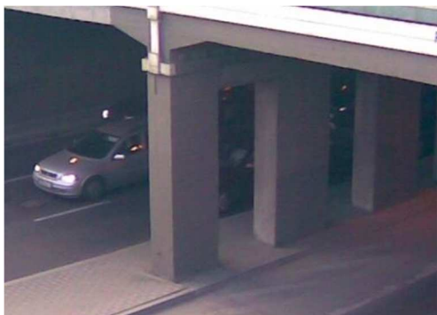
Rys. 3.44. Podpory w tunelu w stanie dobrym
