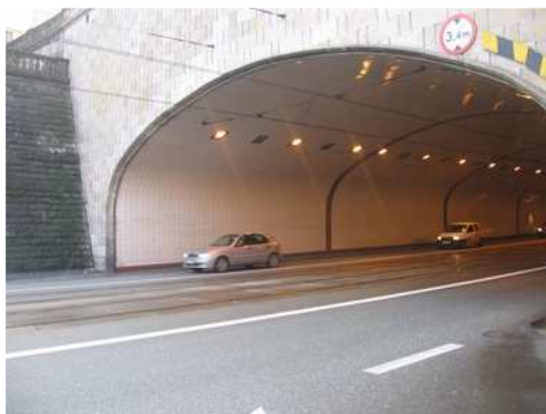
Rys. 3.54. Okładzina ścian i sklepienia tunelu w bardzo dobrym stanie technicznym
