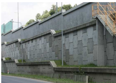
Rys. 5.55. Gzymsy na konstrukcji oporowej bez uszkodzeń
