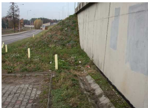
Rys. 5.6. Teren przed konstrukcją bez uszkodzeń, wymagane jedynie usunięcie zanieczyszczeń
