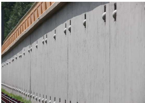
Rys. 5.13. Korpus o konstrukcji betonowej bez uszkodzeń
