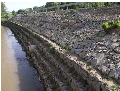
Rys. 5.35. Sporadyczne, niewielkie rośliny nie wpływające negatywnie na trwałość ani estetykę
