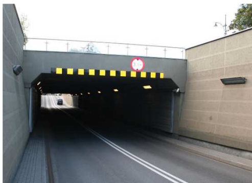
Rys. 3.95. Stan oznakowania tunelu bez zastrzeżeń
