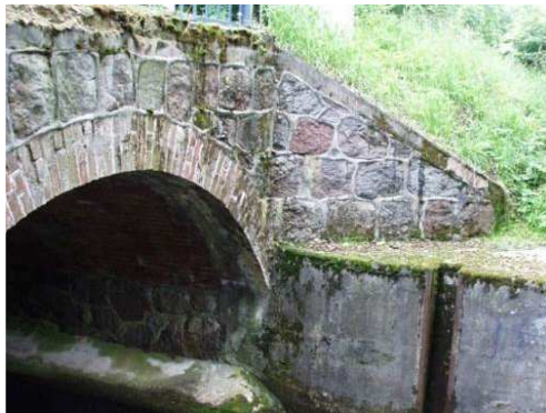
Rys. 4.67. Wegetacja roślin na głowicy wlotowej
