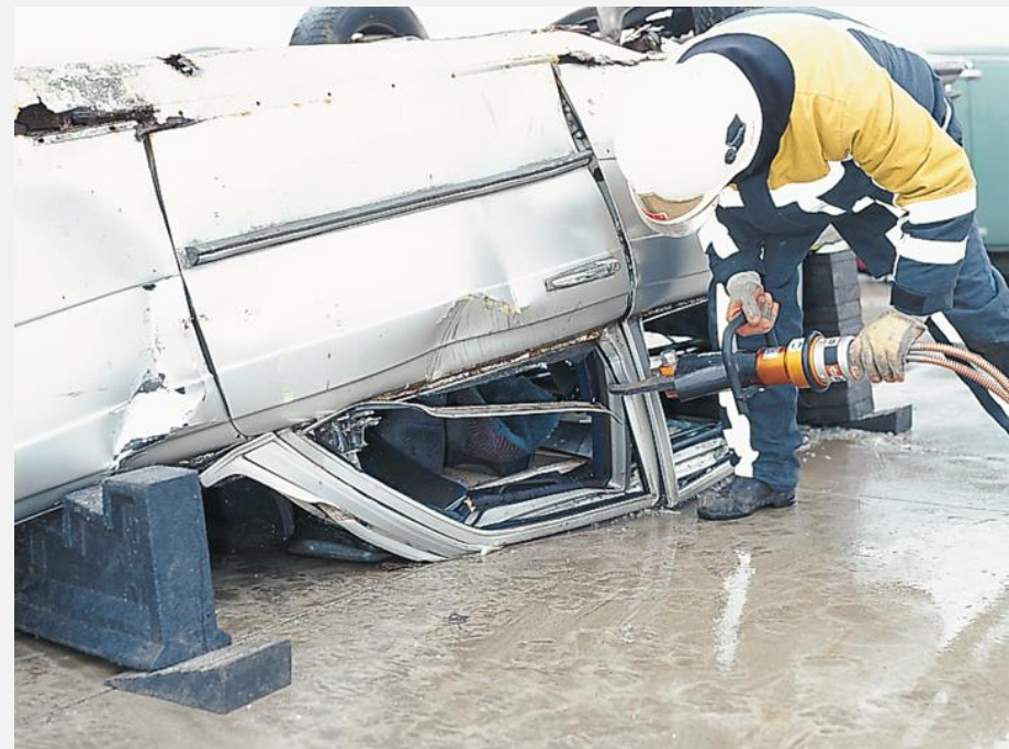
Przecinanie profilu stalowych
