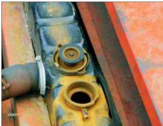
Nieumiejętna obsługa układu chłodzenia fot. OR w Sztumie
