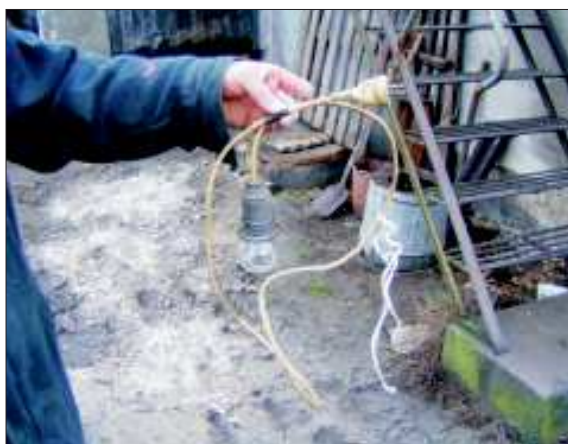
Prowizoryczne podłączenie przewodów elektrycznych, uszkodzona instalacja fot. OR w Koninie
