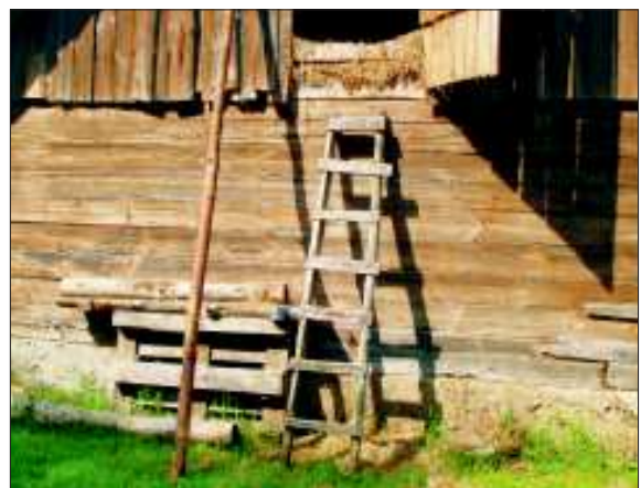
Wadliwie wykonane, źle ustawione, zbyt krótkie drabiny fot. OR w Zambrowie
