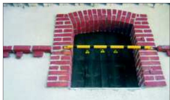
Otwory zrzutowe zabezpieczone barierkami
