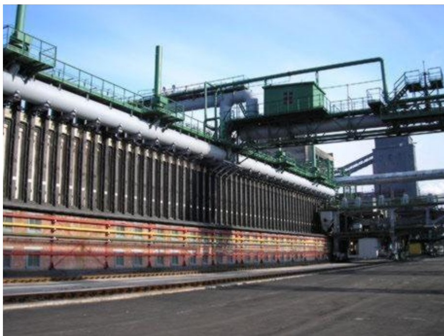
Rys. 3 Bateria koksownicza – strona maszynowa
