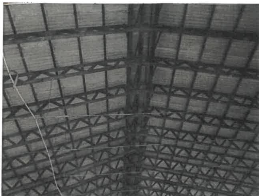
4.Dźwigary dachowe.
