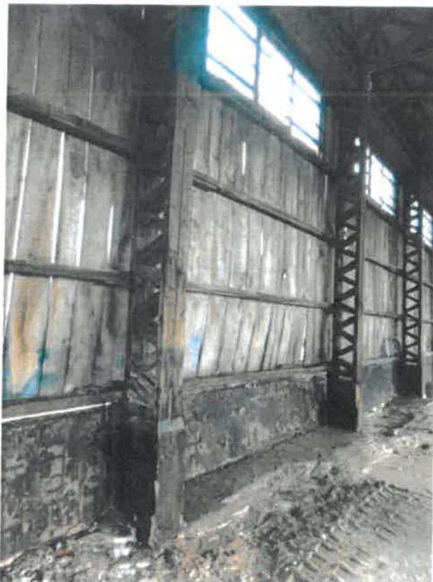
5. Słupy oraz ściany prefabrykowane.
