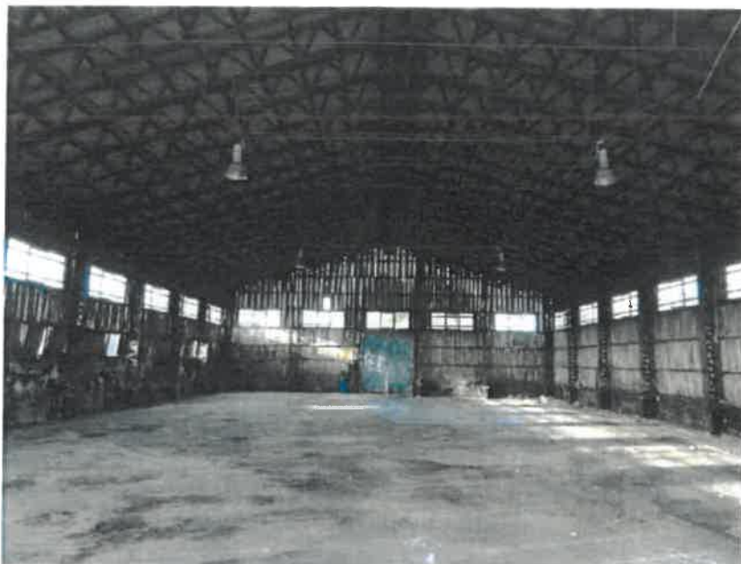
3.Wnętrze magazynu soli.
