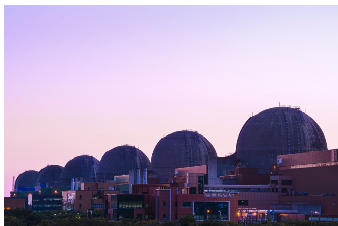
Fot. 1. Sześć bloków Elektrowni Jądrowej Hanbit (d. Yonggwang) zbudowanych w latach 1981–2002. Na zdjęciu widoczne jest sześć kopuł obudów reaktorów: dwóch Westinghouse WH-F i czterech KHNP OPR-1000 (fot. KHNP).
