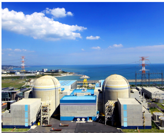
Fot. 2. Bloki 1 i 2 Elektrowni Jądrowej Shin Kori zbudowane na bazie reaktorów OPR-1000 w latach 2006–2012 (fot. KHNP).
