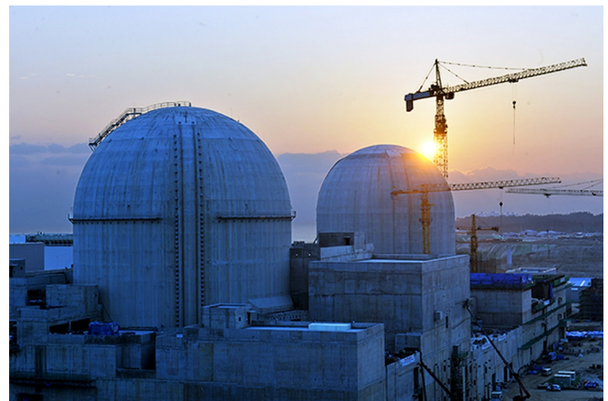
Fot. 4. Bloki 1 i 2 Elektrowni Jądrowej Shin Hanul podczas budowy. Łącznie w tej lokalizacji zainstalowane są dwa francuskie reaktory Framatome CPI (zbudowane w latach 1983–1989), cztery KHNP OPR-1000 (1997–2005) i dwa najnowsze APR-1400, których budowę rozpoczęto w latach 2012–2013. Pierwszy z nich został włączony do eksploatacji w krajowej sieci elektroenergetycznej 7 grudnia 2022 r. (fot. KHNP).
