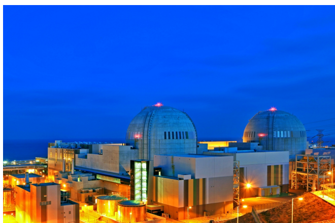
Fot. 3. Elektrownia Jądrowa Shin Wolsong w nocnej scenerii. Na zdjęciu dwa bloki na bazie reaktorów OPR-1000. W starszej części EJ Wolsong pracują 4 bloki z ciężkowodnymi, ciśnieniowymi (PHWR) reaktorami typu CANDU-6 produkcji kanadyjskiej (fot. KHNP).
