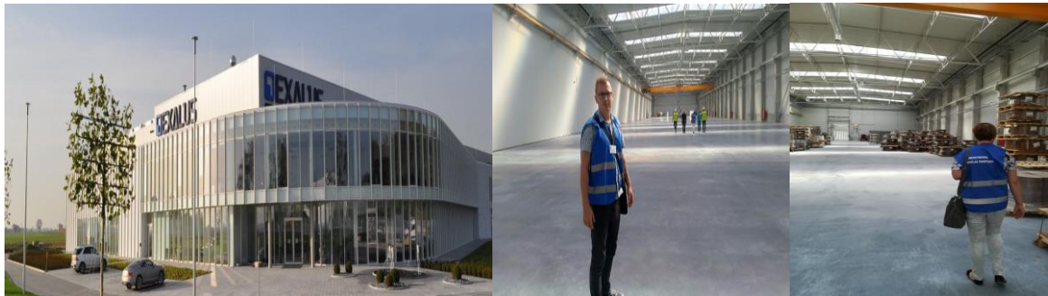
zdjęcia nr 48,49,50. Rozbudowa zakładu produkcyjno – magazynowego z częścią biurowo – socjalną w miejscowości Kuchary - EXALUS TR7 z Sp. o. o. Sp. K.
