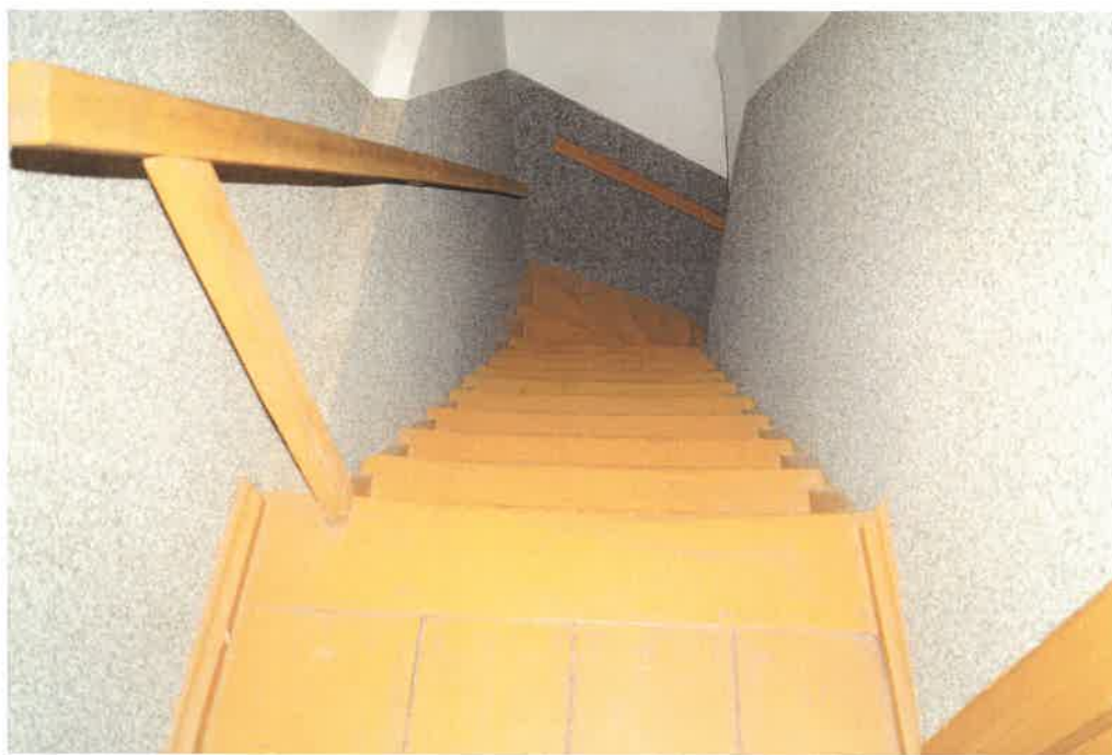
Widok schodów ze spocznikiem.
