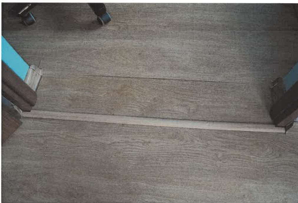
Istniejące panele podłogowe
