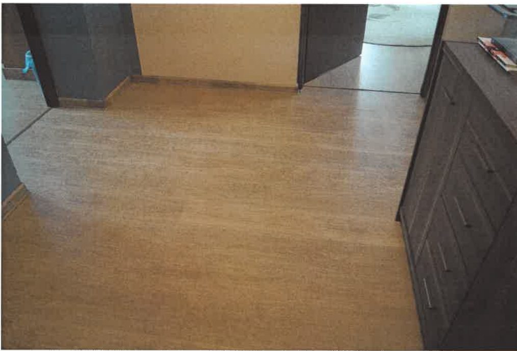
Istniejące panele podłogowe
