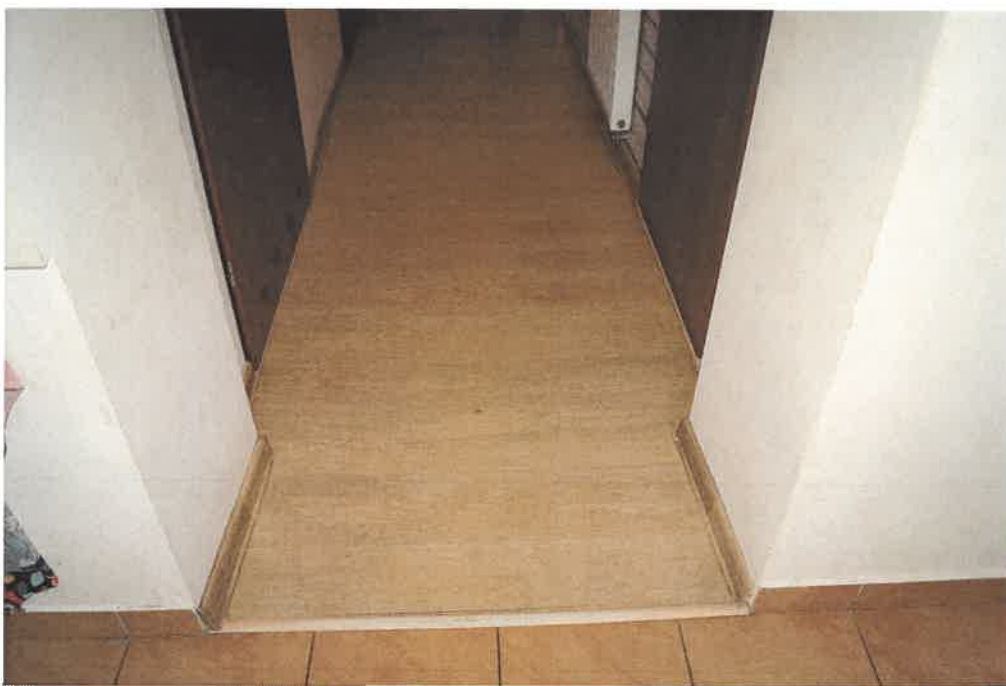
Istniejące panele podłogowe w korytarzu
