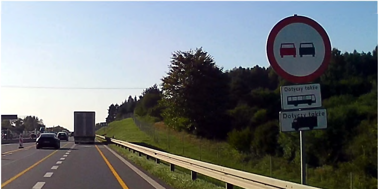
Zdjęcie 2: Znak B-25 z tabliczkami „dotyczy także” wraz z symbolami autobusu i pojazdu ciężarowego (autostrada A4, okolice Chrzanowa)
