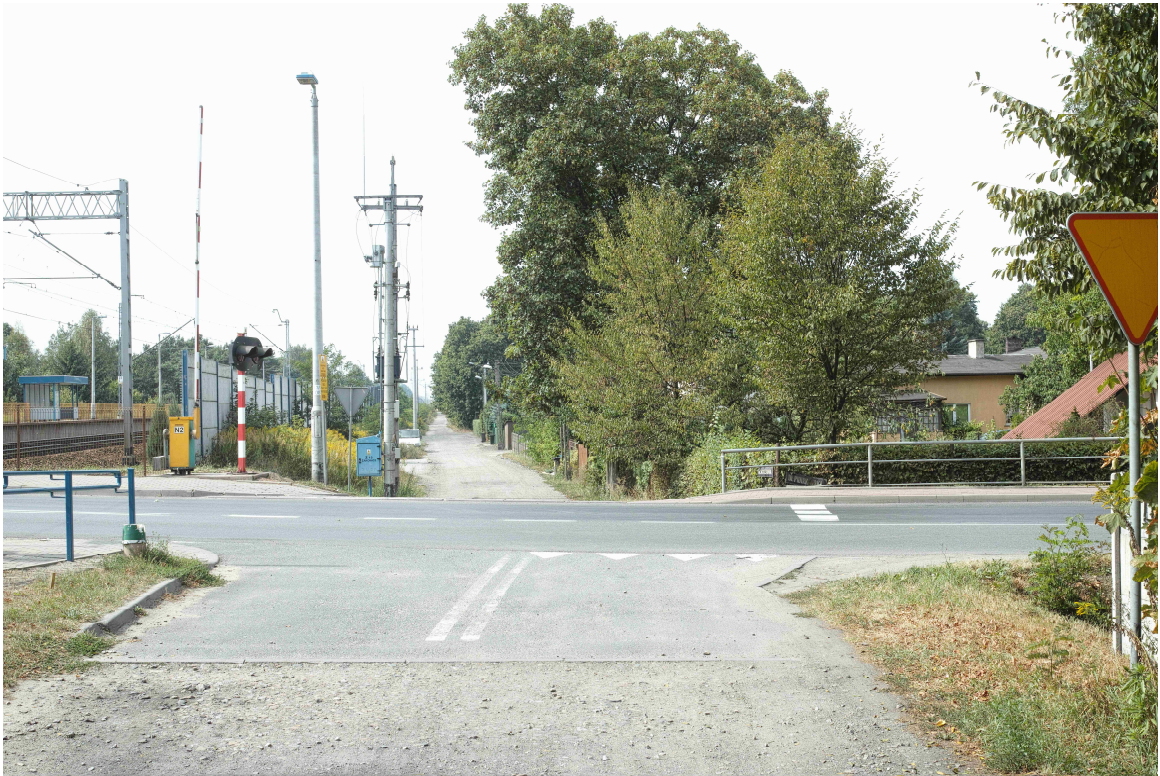
Fot. 1. Widok w osi ul. Kolejowej, w kierunku Gałkówka.
