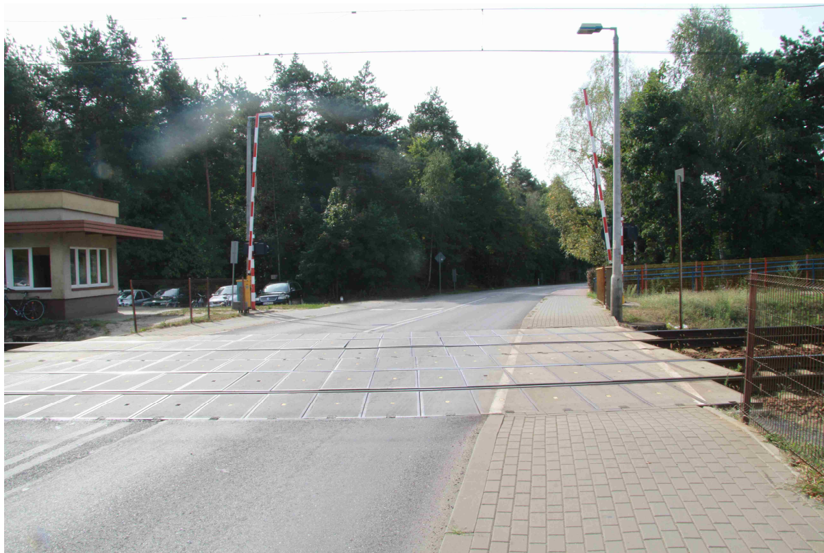
Fot. 6. Widok ogólny przejazdu od strony toru nr 2.
