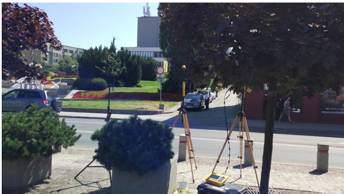
Fot.3. Rejon badań, widok w kierunku wschodnim
