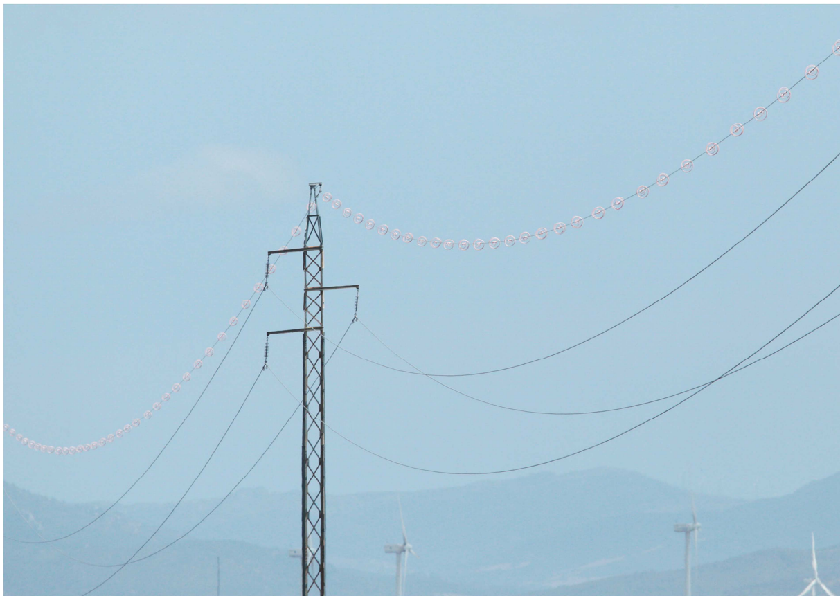
Fot. 11. Spirale zwiększające widoczność linii zamontowane na górnym, odgromowym przewodzie, południowa Hiszpania – fot. K. Skakuj.
