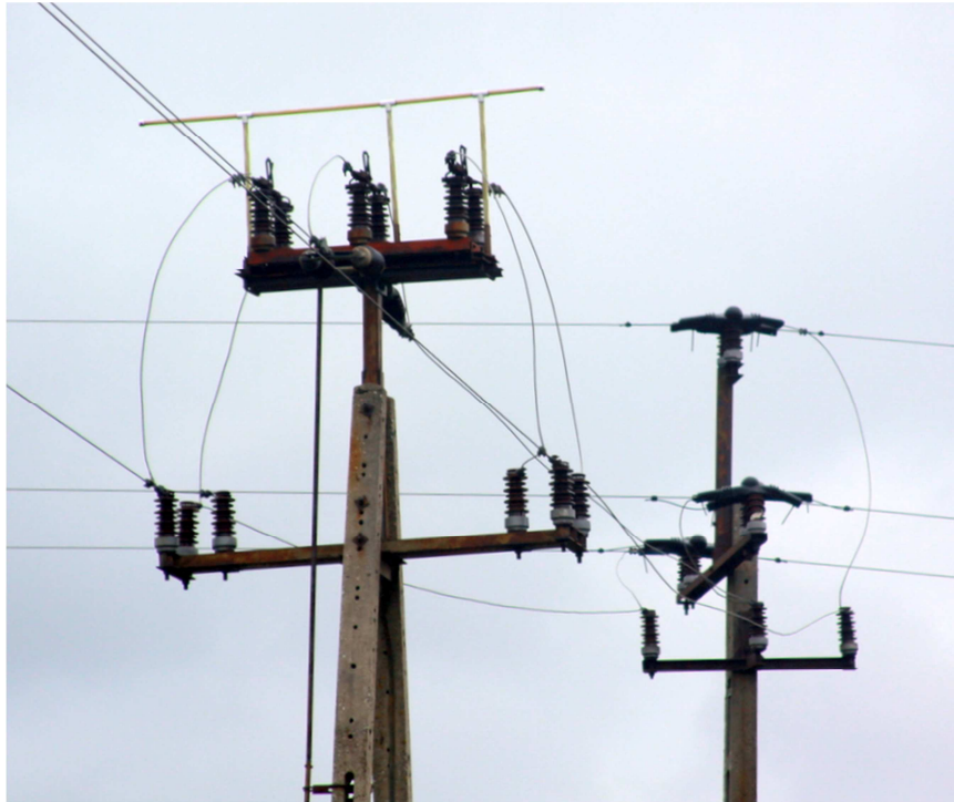
Fot. 14 i 15. Przykłady prowizorycznych poprzeczek (grzęd) utrudniających ptakom bezpośredni kontakt z niebezpiecznymi elementami, bez zmiany w konfiguracji niebezpiecznych konstrukcji urządzeń słupów (powyżej słup rozłącznikowy, poniżej słup ze stacją transformatorową); fot. I. K.
