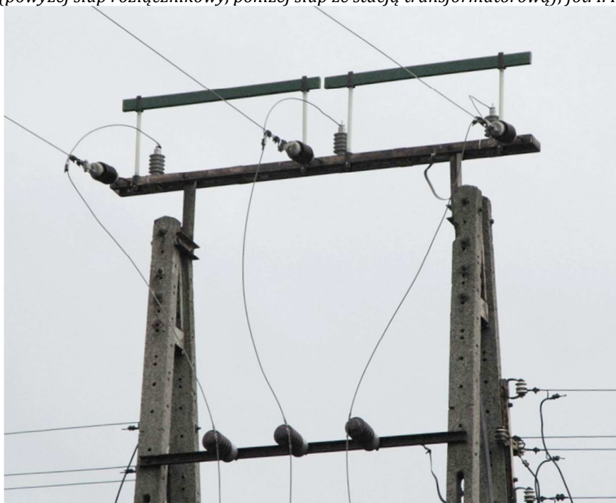
Fot. 14 i 15. Przykłady prowizorycznych poprzeczek (grzęd) utrudniających ptakom bezpośredni kontakt z niebezpiecznymi elementami, bez zmiany w konfiguracji niebezpiecznych konstrukcji urządzeń słupów (powyżej słup rozłącznikowy, poniżej słup ze stacją transformatorową); fot. I. K.
