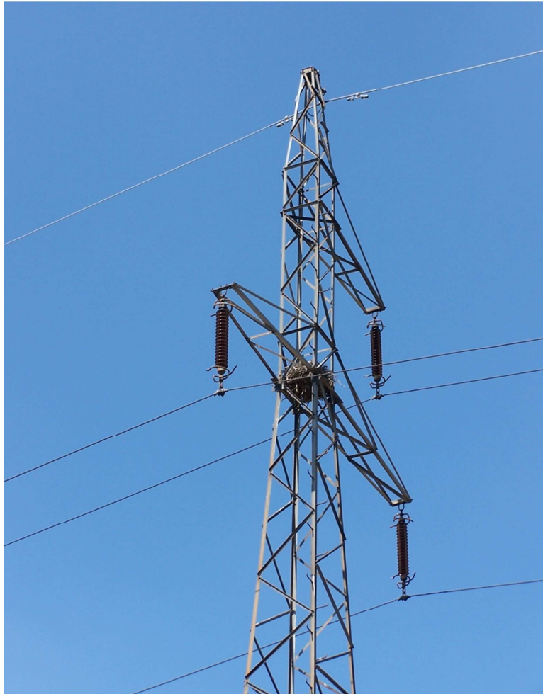
Fot. 6. Gniazdo kruk Corvus corax posadowione na kratownicy słupa linii 110 kV, fot. I. K.
