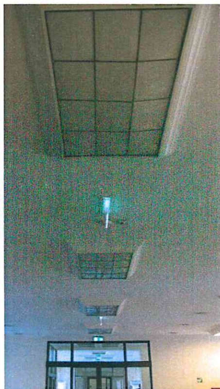
Fotografia 3 Hall wejściowy - oprawa architektoniczna świetlówkowa – prostokąt
