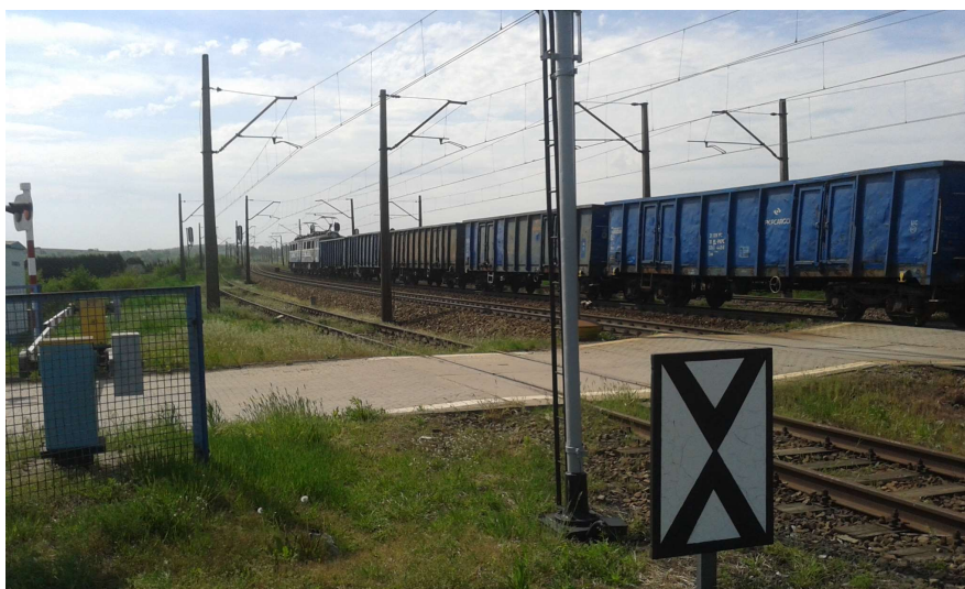
Fot. 2. Orzech, RB1. Linia kolejowa nr 131 w kierunku Radzionkowa.
