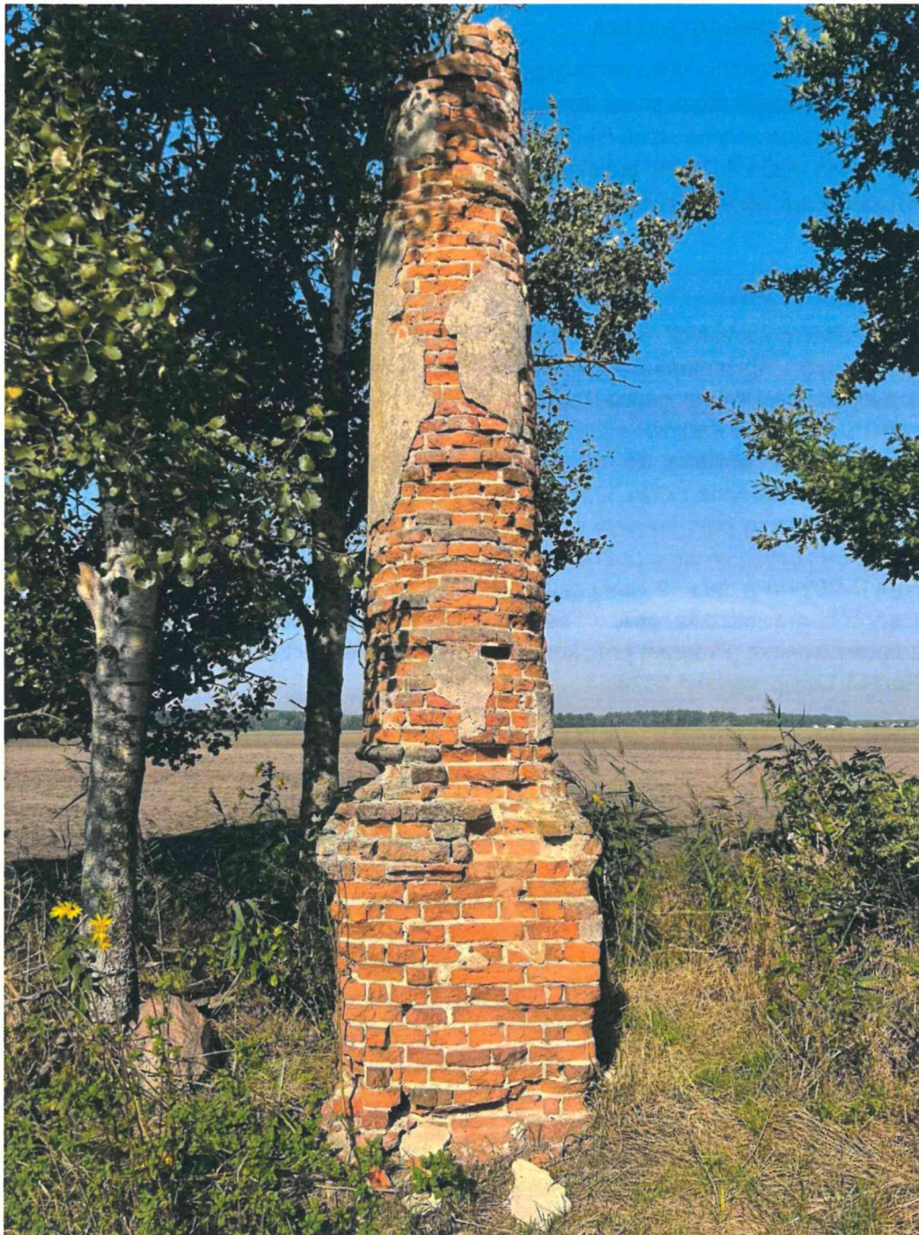
Fot. 1. WIDOK OD STRONY POŁUDNIOWEJ
