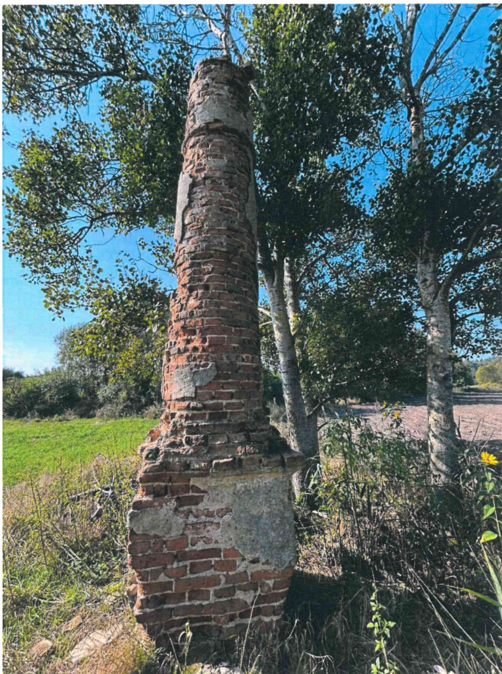
Fot. 2. WIDOK OD STRONY WSCHODNEJ
