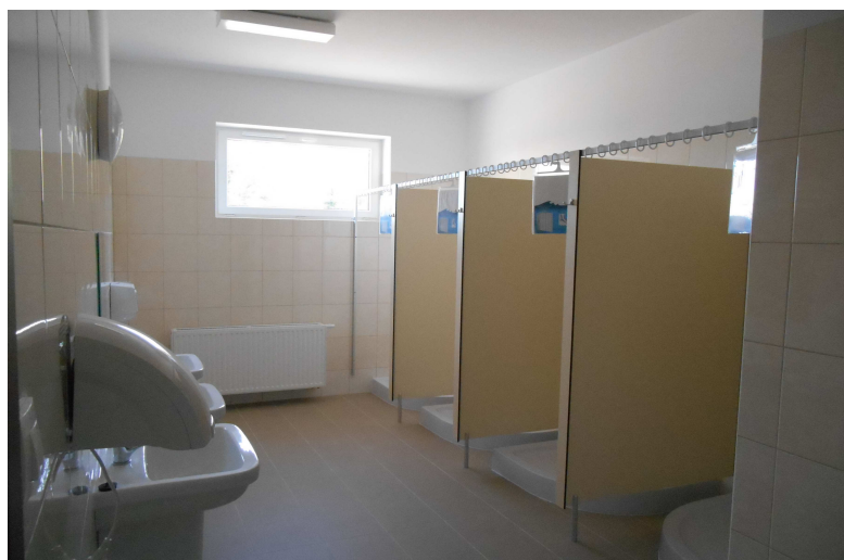
Zaplecze sanitarne przy sali gimnastycznej przy Zespole Szkół w Zasutowie
