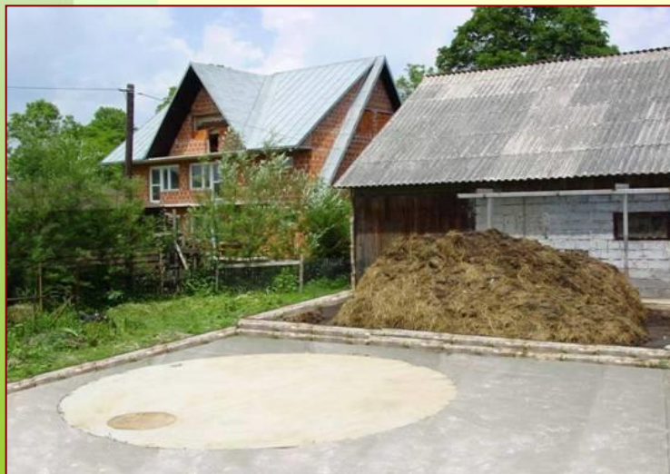
Płyta gnojowa ze zbiornikiem na gnojówkę
