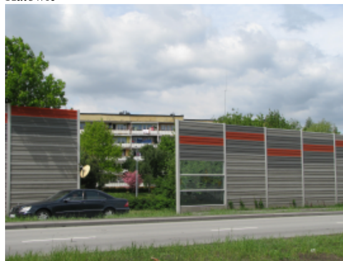
Fot. 4. Żory, RB1, ekran akustyczny wzdłuż ul. Kościuszki (DK 81)
