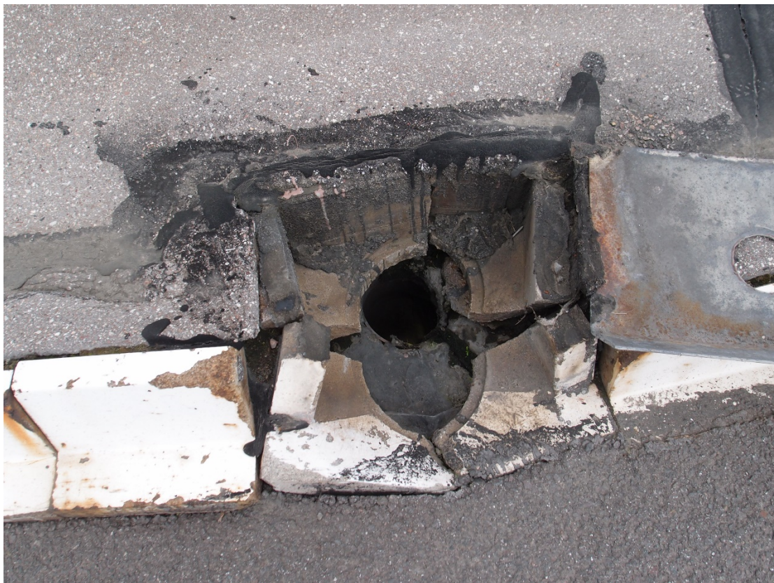
Fot. 10 Bobrowniki, DK 65 km 215+126. Przemieszczony krawężnik i spękany wpust odwodnieniowy na początku przęsła nr 1 - strona lewa.
