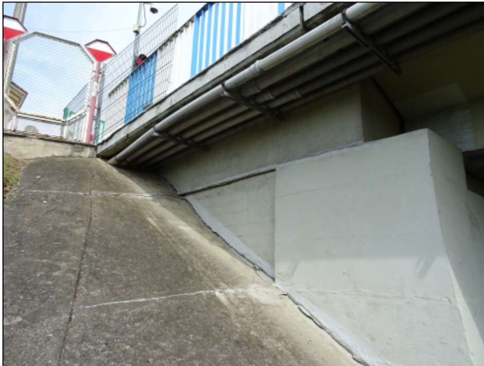
Fot. 4 Bobrowniki, DK 65 km 215+126. Rysy na umocnieniu stożka przy przyczółku nr 1 (początek mostu). 19.07.2023 r.
