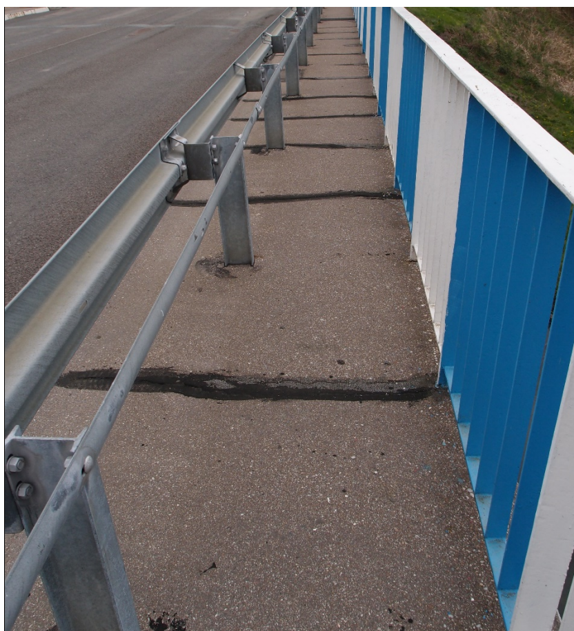
Fot. 13 Bobrowniki, DK 65 km 215+126. Rysy w nawierzchni chodnika z asfaltu lanego - strona prawa.
