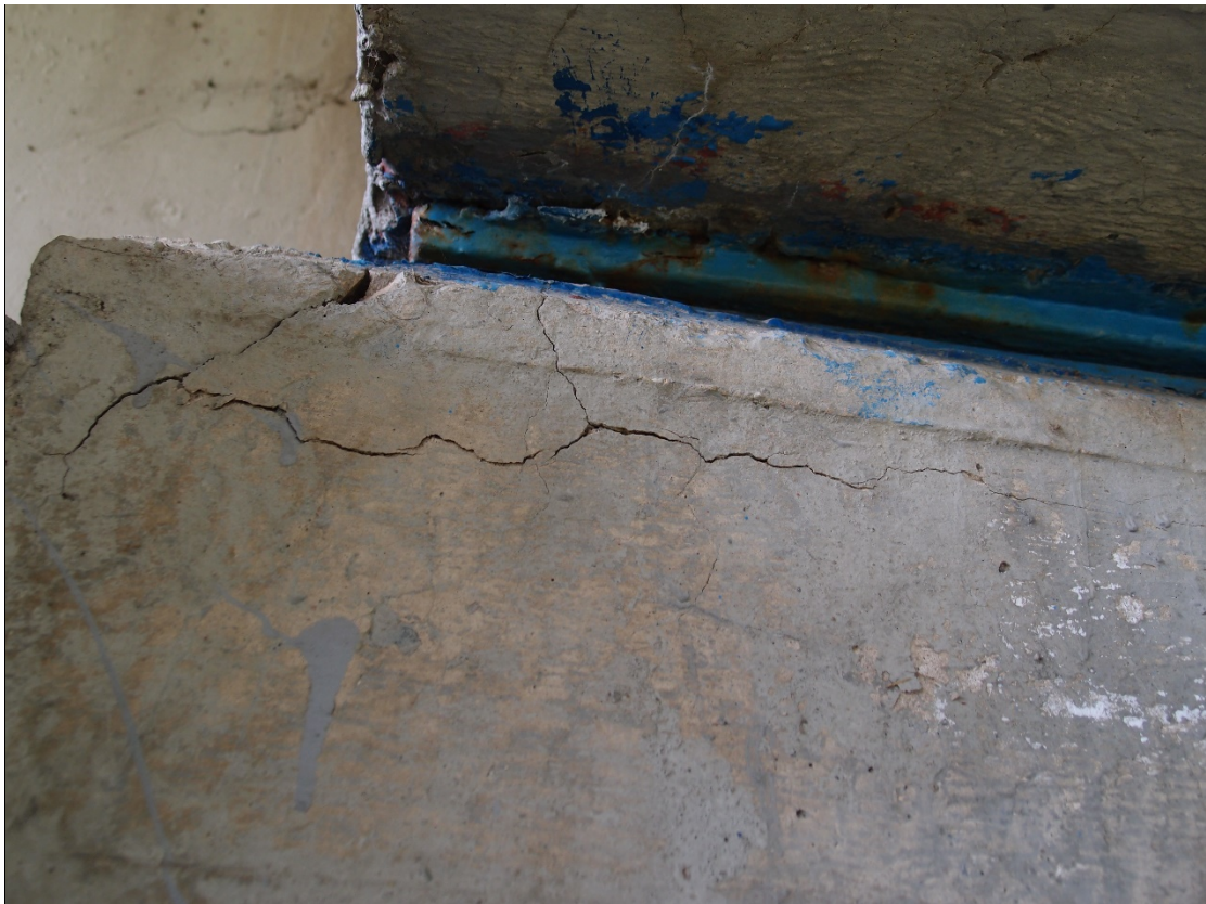
Fot. 18 Bobrowniki, DK 65 km 215+126. Rysy w wahaczu łożyska przy przyczółku na początku mostu - strona prawa.
