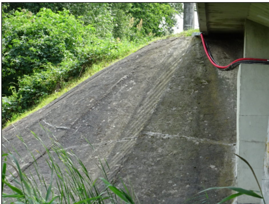
Fot. 5 Bobrowniki, DK 65 km 215+126. Rysy na umocnieniu stożka przy przyczółku nr 4 (koniec mostu). 19.07.2023 r.
