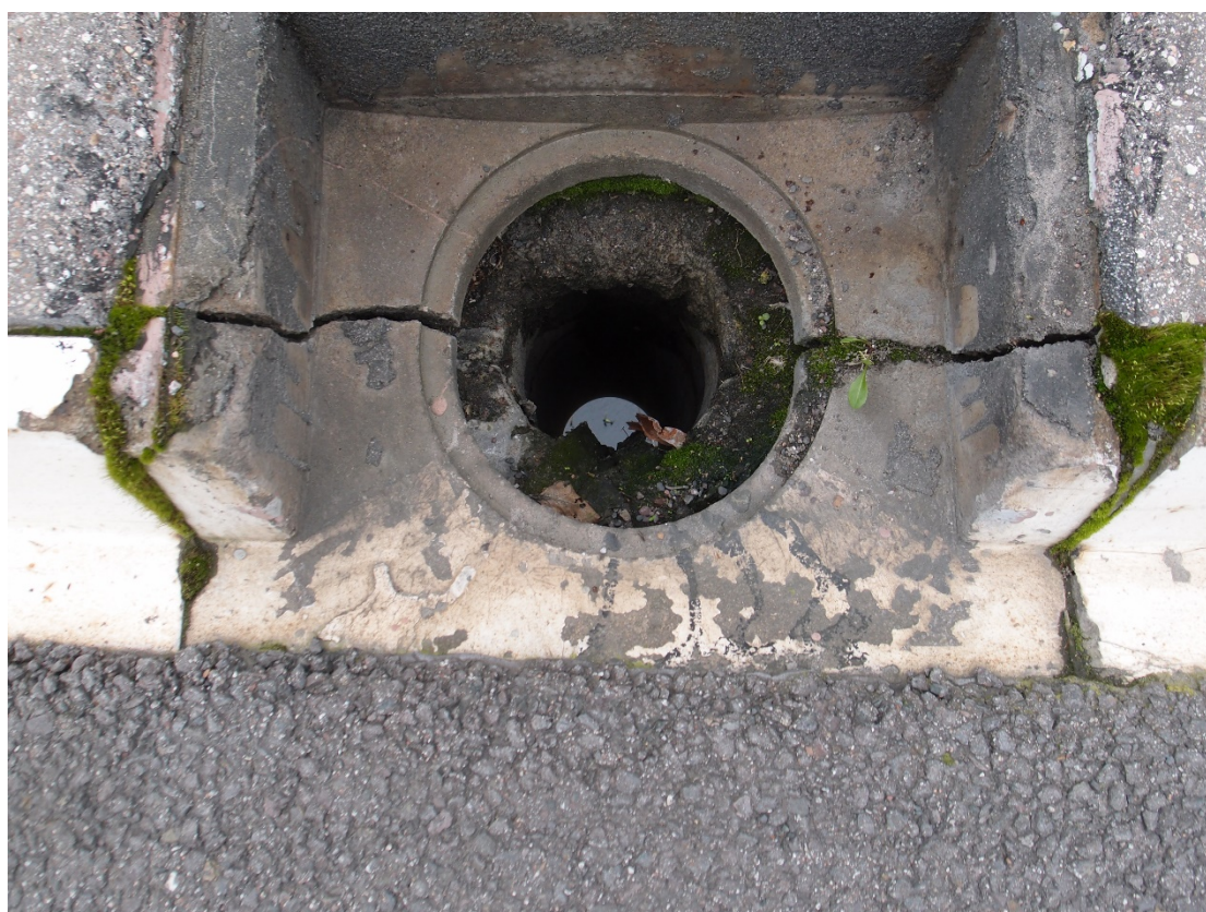
Fot. 15 Bobrowniki, DK 65 km 215+126. Spękany wpust odwodnieniowy na przęśle nr 2 - strona prawa.
