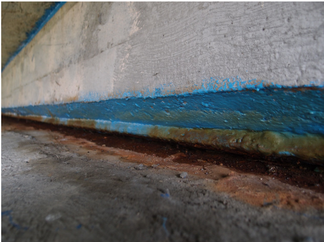
Fot. 19 Bobrowniki, DK 65 km 215+126. Korozja blach łożyska wahaczowego na początku mostu.
