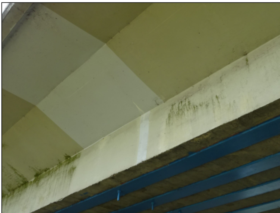
Fot. 17 Bobrowniki, DK 65 km 215+126. Rysa i zaciek w wsporniku podchodnikowym w przęśle nr 1 - strona lewa.
