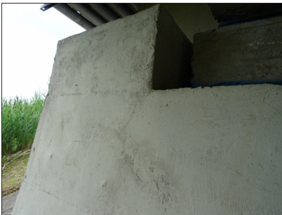
Fot. 23 Bobrowniki, DK 65 km 215+126. Rysa w ścianie czołowej przyczółka nr 1 w okolicy ławy podłożyskowej, początek mostu - strona prawa.
