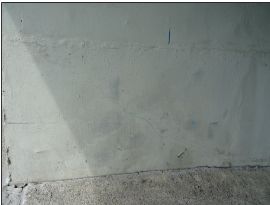
Fot. 22 Bobrowniki, DK 65 km 215+126. Rysy w ścianie czołowej przyczółka nr 1, początek mostu - strona prawa.
