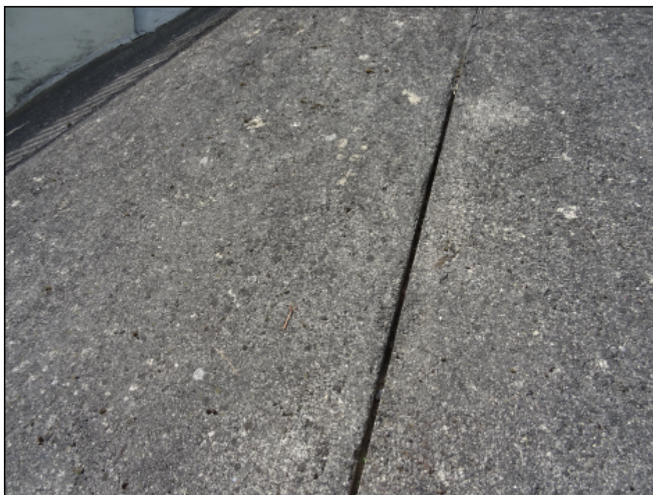
Fot. 3 Bobrowniki, DK 65 km 215+126. Brak wypełnienia szczeliny w stożku przy przyczółku nr 1 (początek mostu). 19.07.2023 r.
