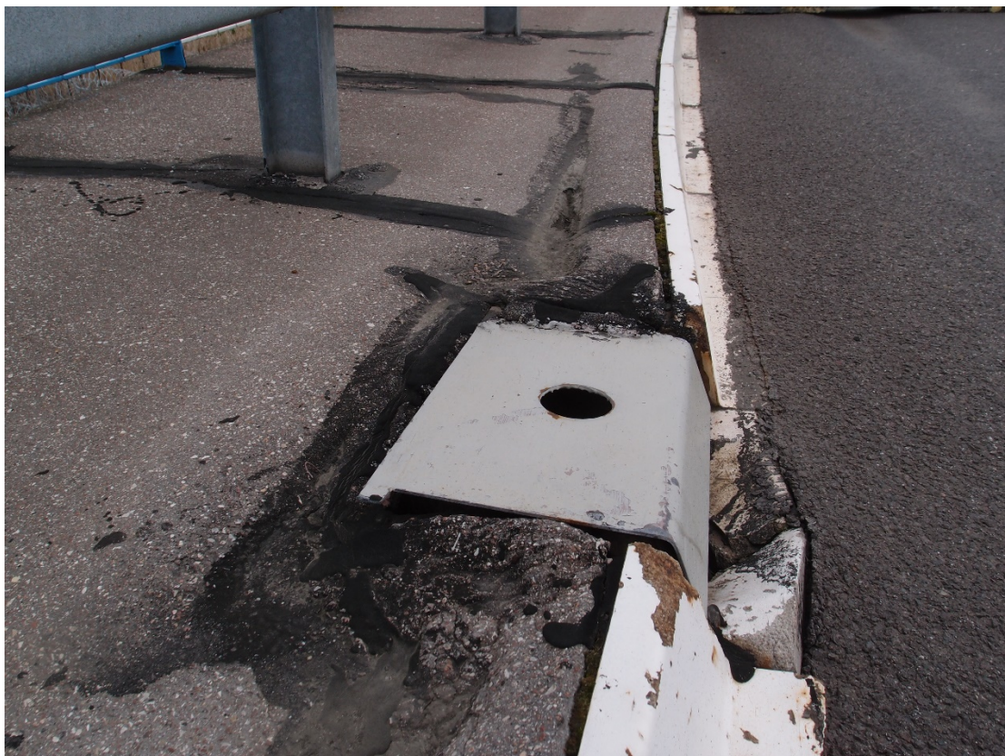
Fot. 9 Bobrowniki, DK 65 km 215+126. Przemieszczony krawężnik i wpust odwodnieniowy na początku przęsła nr 1 - strona lewa.
