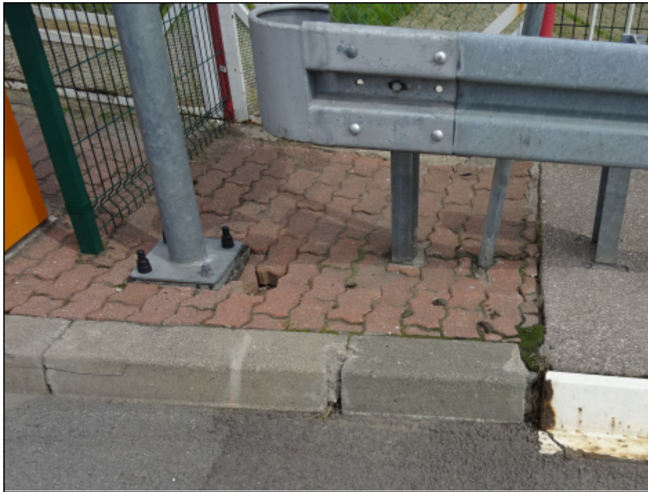
Fot. 8 Bobrowniki, DK 65 km 215+126. Zapadnięta kostka betonowa i nierówności progowe przy połączeniu chodnika na dojeździe z chodnikiem na obiekcie, początek mostu - strona lewa.
