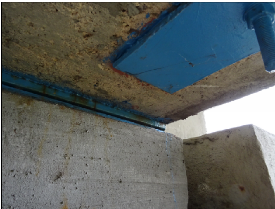
Fot. 20 Bobrowniki, DK 65 km 215+126. Korozja blach łożyska na początku mostu - strona lewa.
