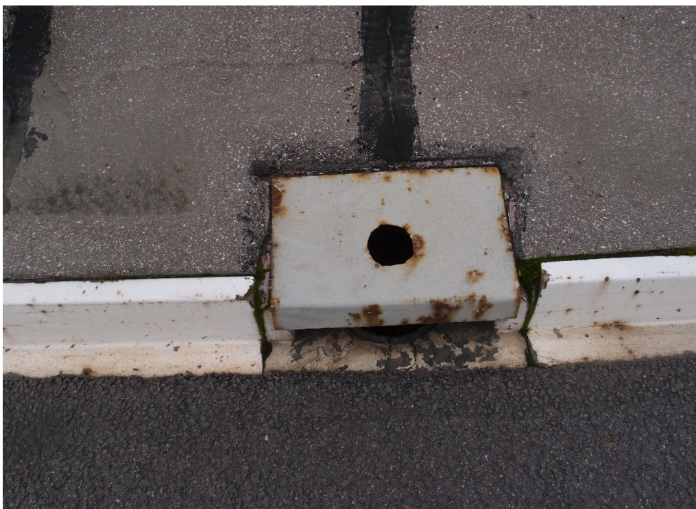
Fot. 14 Bobrowniki, DK 65 km 215+126. Korozja pokrywy wpustu odwodnieniowego na przęśle nr 2 - strona prawa.
