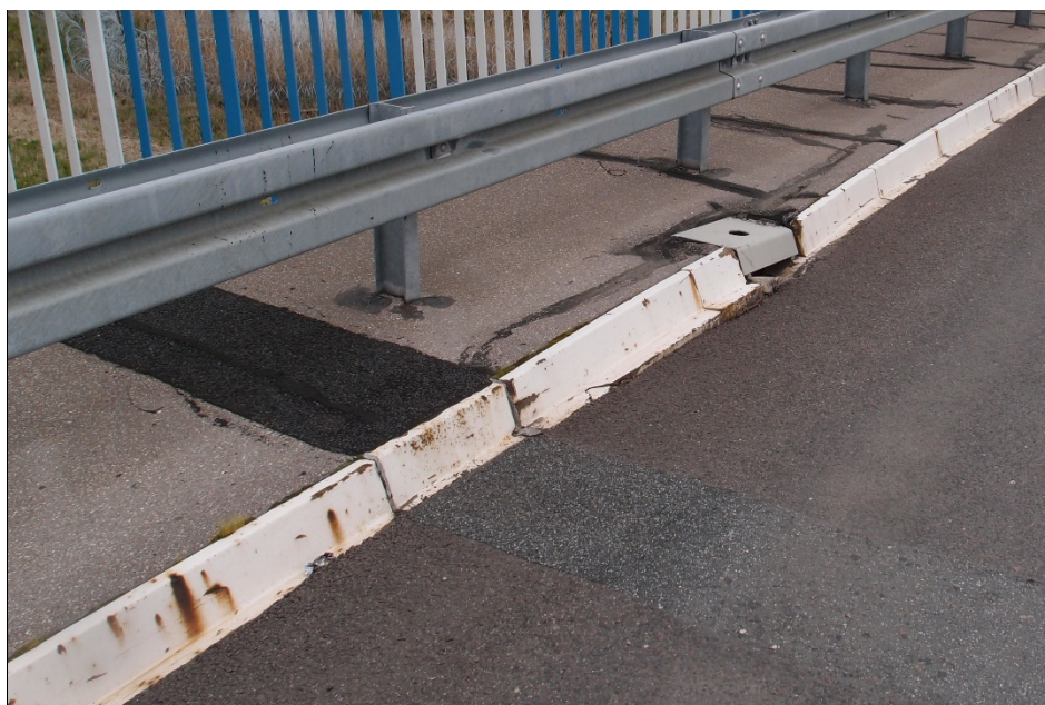
Fot. 11 Bobrowniki, DK 65 km 215+126. Rysy w nawierzchni chodnika z asfaltu lanego i rdzawe zacieki na powierzchni krawężników z polimerobetonu - strona lewa. 12.04.2024 r.
