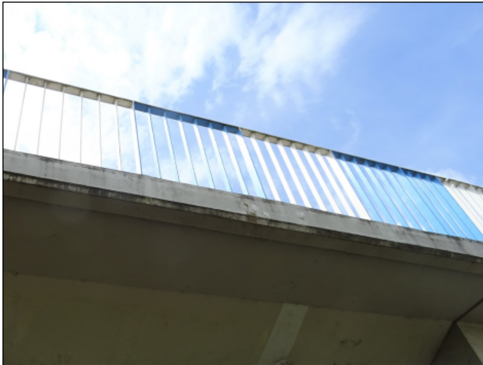
Fot. 16 Bobrowniki, DK 65 km 215+126. Uszkodzone zabezpieczenie antykorozyjne betonu na powierzchni belki podporęczowej na początku mostu, strona lewa.
