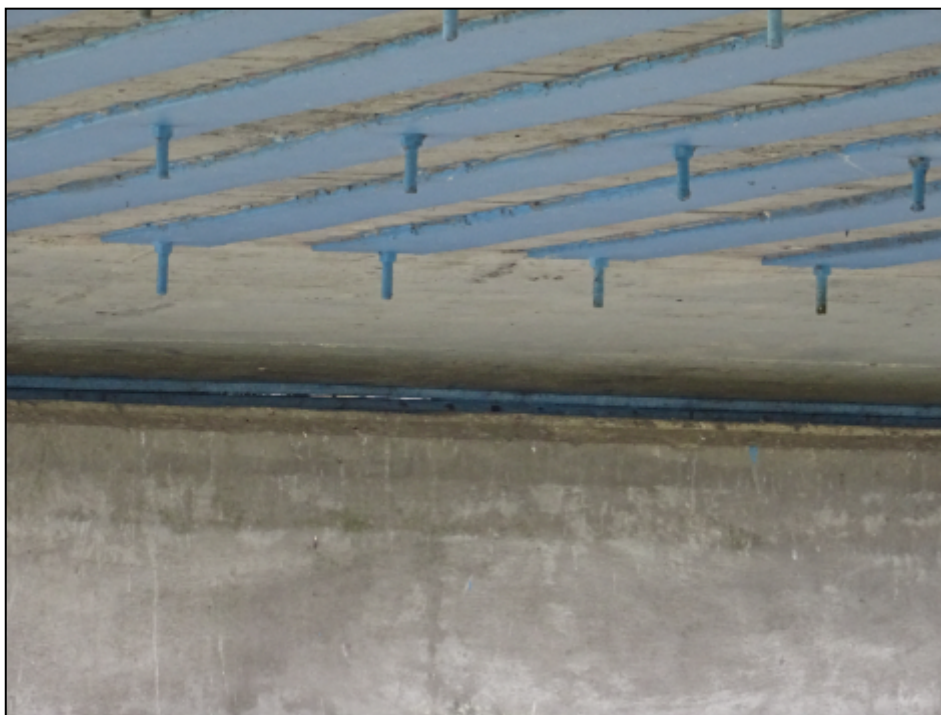
Fot. 21 Bobrowniki, DK 65 km 215+126. Prześwit pomiędzy blachami łożyska nad filarem nr 3.
