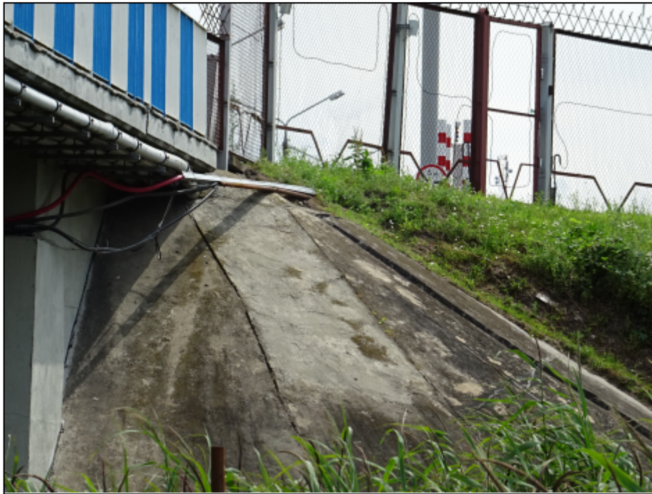
Fot. 6 Bobrowniki, DK 65 km 215+126. Brak wypełnienia szczeliny w stożku przy przyczółku nr 4 (koniec mostu). 19.07.2023 r.
