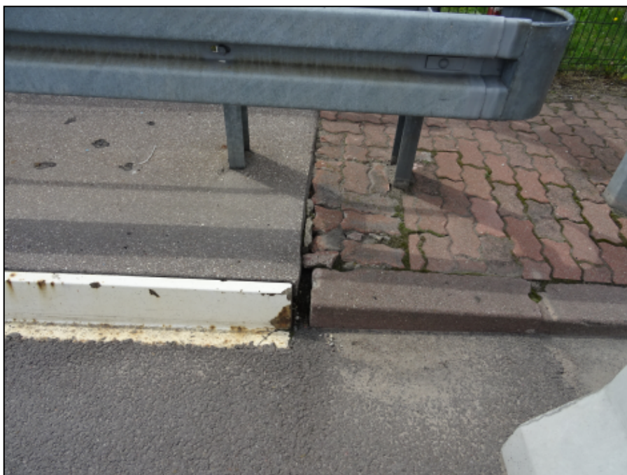
Fot. 12 Bobrowniki, DK 65 km 215+126. Rozszczelniony styk i nierówności progowe przy połączeniu chodnika na dojeździe z chodnikiem na obiekcie na początku mostu - strona prawa.
