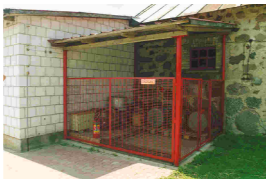
Wydzielone miejsce do składowania paliw płynnych.
