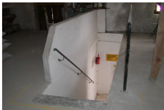
Oświetlone wejście na poddasze z solidną poręczą przy schodach.
