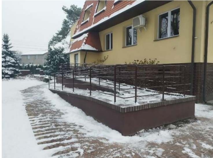
Rycina 7. Budynek biurowy – podjazd dla osób niepełnosprawnych.
