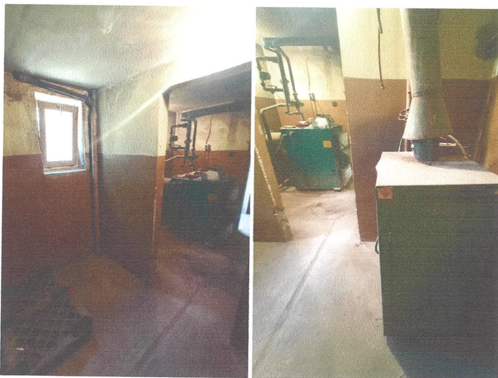
Stan istniejący kotłowni
