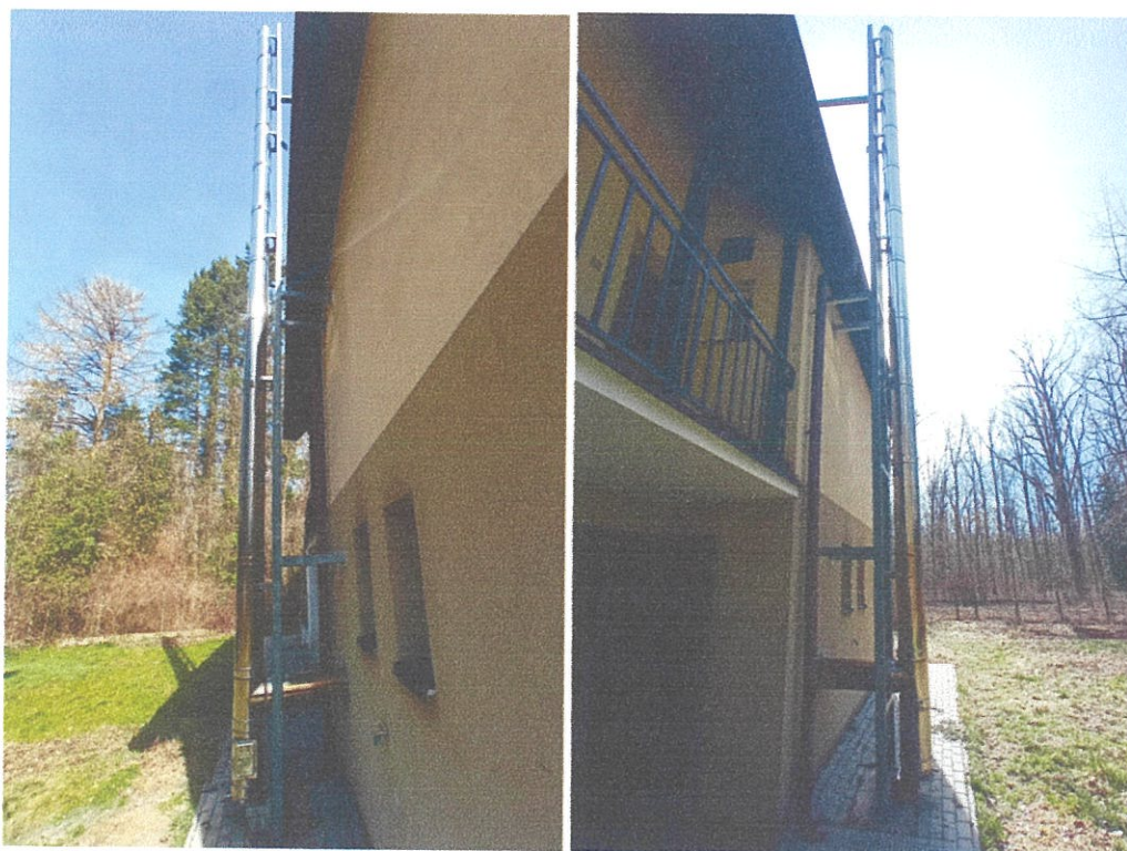
Komin zewnętrzny do odprowadzania spalin do rozbiórki
