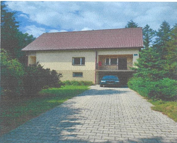
Widok ogólny budynku
