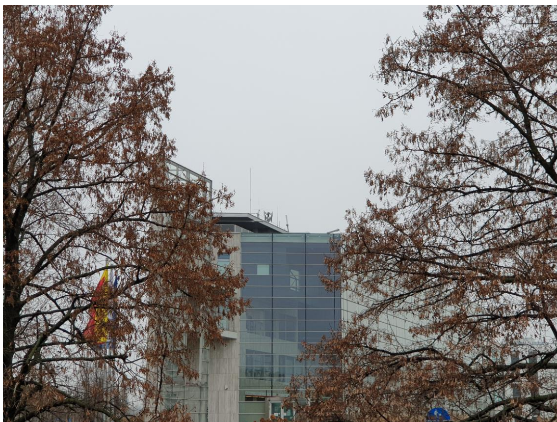
Rys. 3 Miejsce montażu SELMS PEM – UD Wilanów – widok z poziomu gruntu
