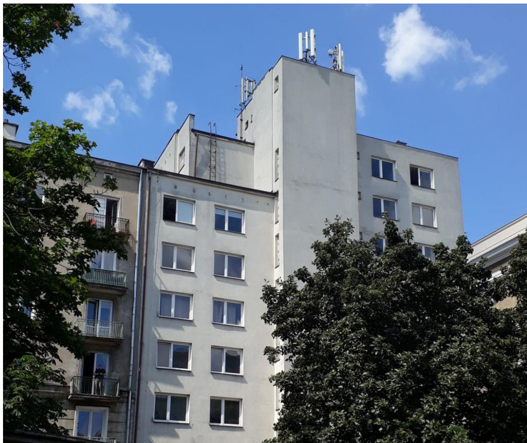
Fot. 1: Widok anten stacji bazowej ID: WAR1030F, zlokalizowanej pod adresem: Al. Jana Pawła II 34, 00-141 Warszawa
