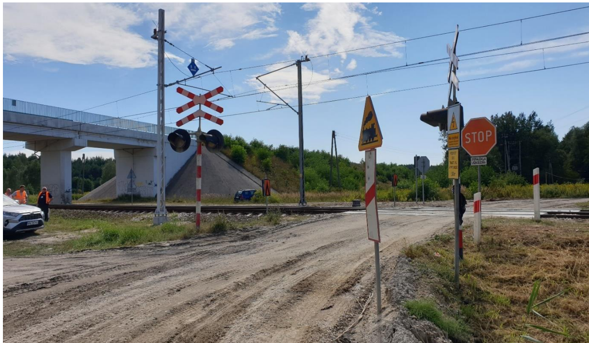
Zdjęcie 5 - Widoczność z drogi dojazdowej z lewej strony przejazdu – widoczność sygnalizatora drogowego SSP – źródło: dokumentacja PKBWK, zdjęcie z dnia wypadku
