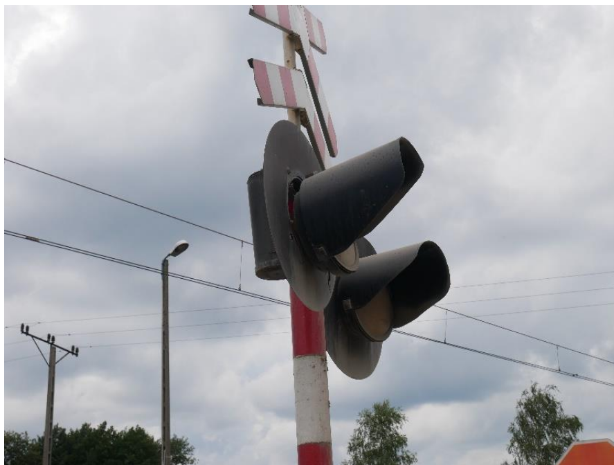
Zdjęcie 8 - Sygnalizatory drogowy od strony lewej przejazdu słabo widoczne dla kierowcy samochodu ciężarowego – źródło: dokumentacja PKBWK, zdjęcie z dnia wypadku
