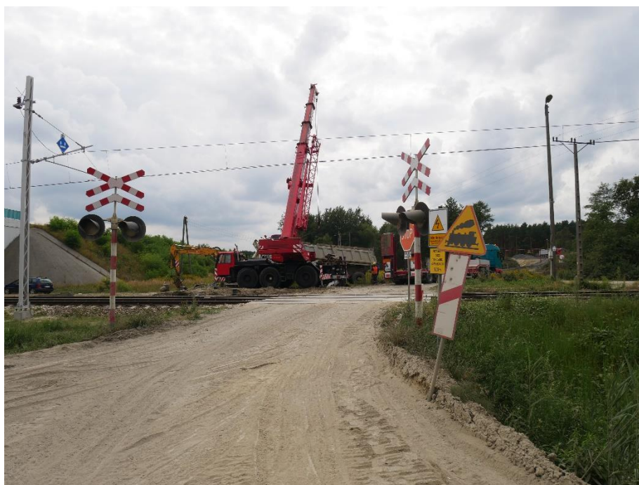
Zdjęcie 8 - Sygnalizatory drogowy od strony lewej przejazdu słabo widoczne dla kierowcy samochodu ciężarowego – źródło: dokumentacja PKBWK, zdjęcie z dnia wypadku
