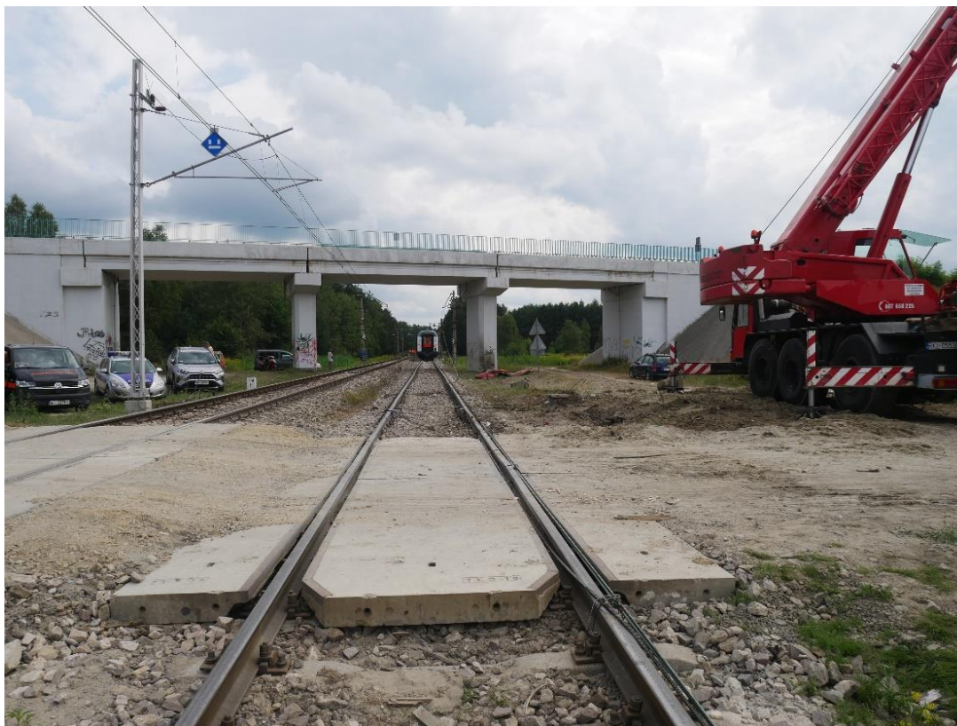
Zdjęcie 6 – Nawierzchnia od strony lewej przejazdu – źródło: dokumentacja PKBWK, zdjęcie z dnia wypadku
