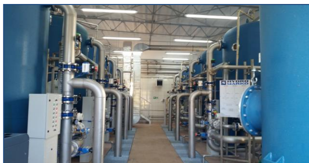
FOT. Wodociąg publiczny w Gozdnicy – budynek Stacji Uzdatniania Wody, urządzenia filtrujące po przeprowadzonej modernizacji
