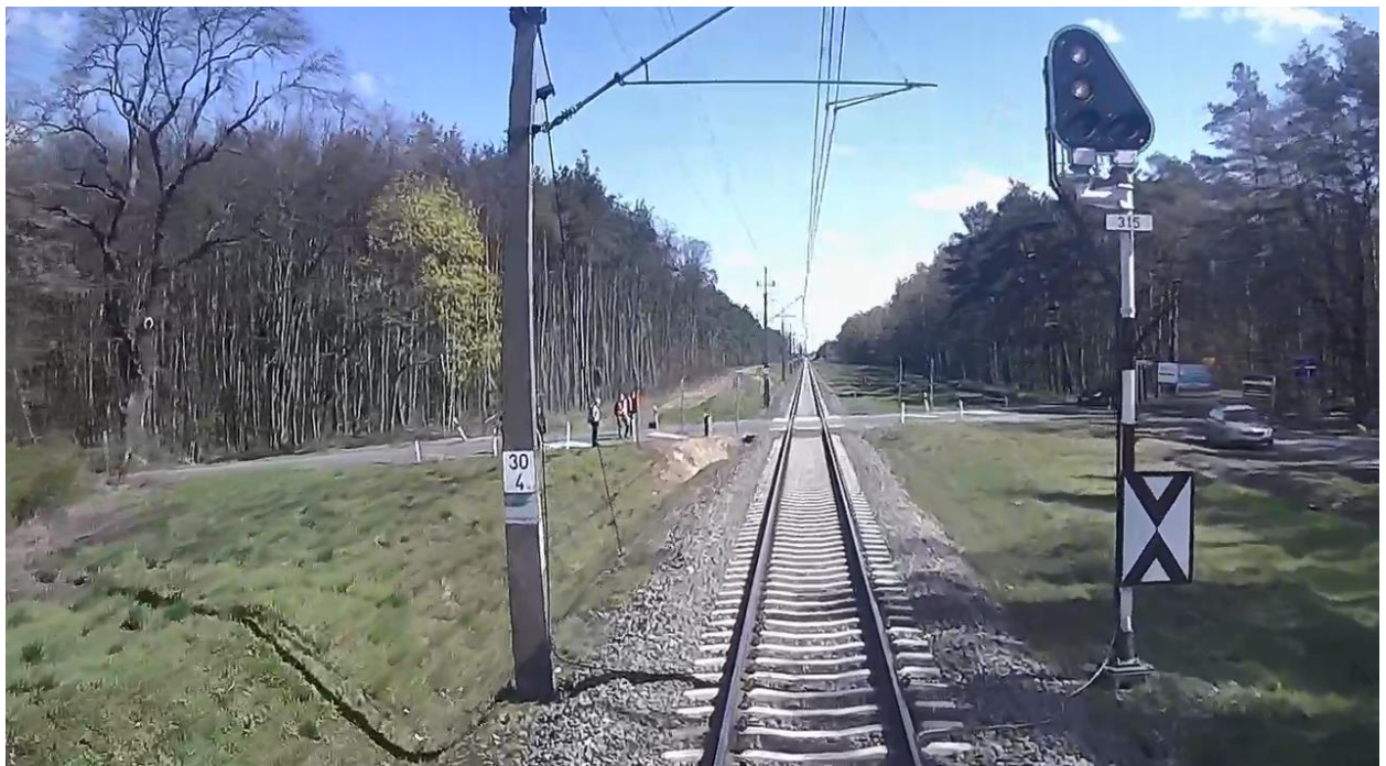
Zdjęcie 3. Widok przejazdu kolejowo-drogowego z kabiny pojazdu kolejowego z kierunku jazdy pociągu (źródło: PKBWK)
