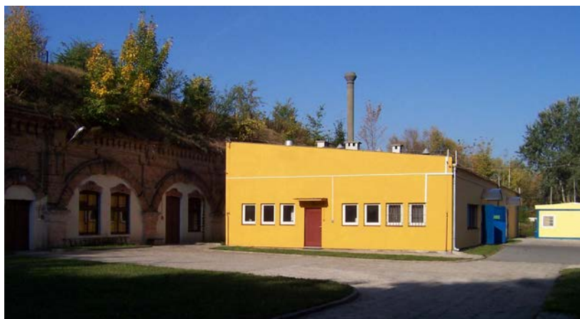
Rys. 7.2a. Stacja Radiacyjnego Utrwalania Płodów Rolnych IChTJ
