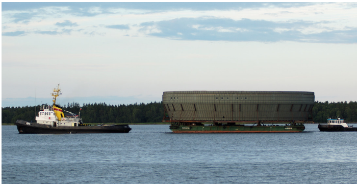
Fot. 18. Zdjęcie przedstawiające transport okładziny z portu w Gdyni do Olkiluoto w Finlandii (na plac budowy) (fot. TVO/Hannu Huovila)
