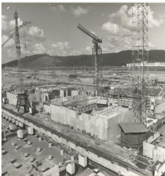
Fot. 1. Budowa EJ Żarnowiec (fot. Stanisław Wiesiołowski).
