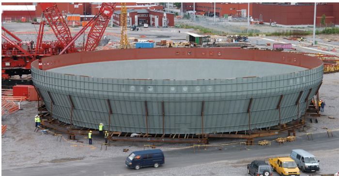
Fot. 17. Dolna część stalowej okładziny (tzw. liner) do budynku reaktora EPR w Olkiluoto – wykonana przez Energomontaż-Północ Gdynia.
