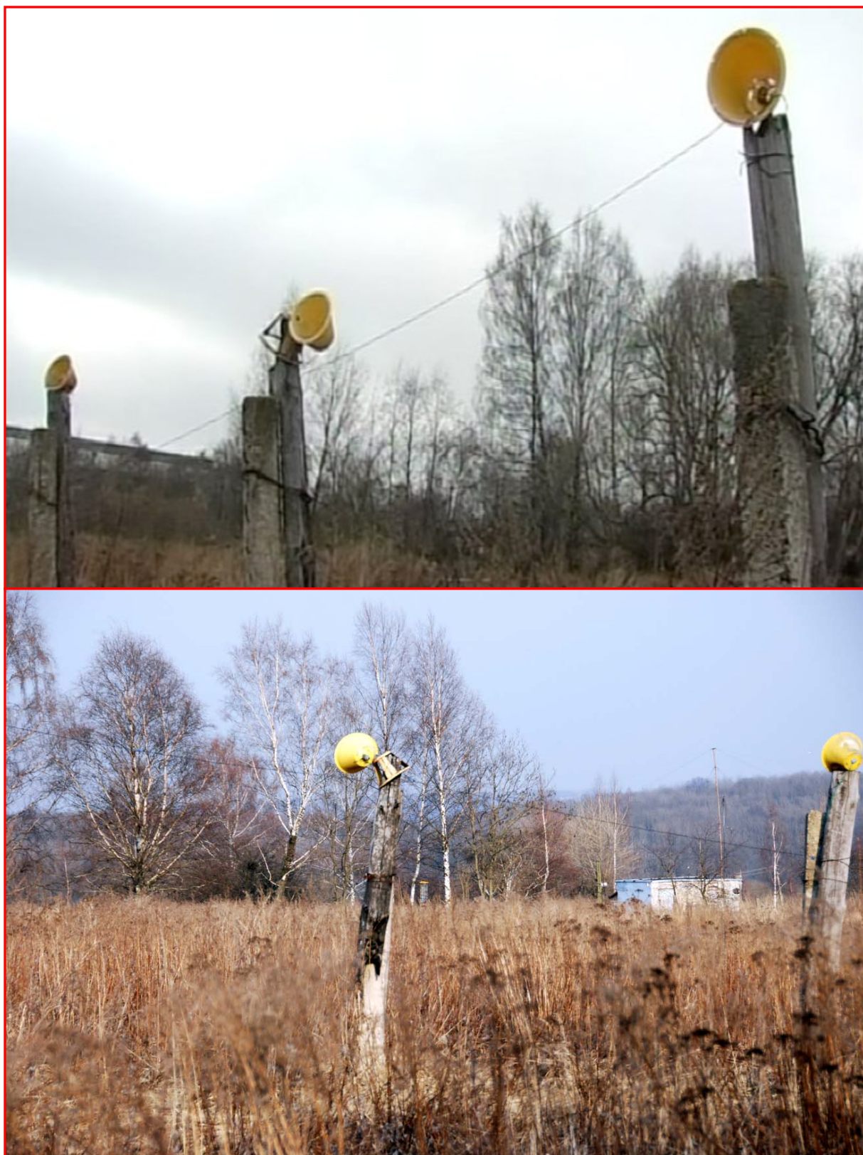
Fot. 22. Stan techniczny świateł podejścia
