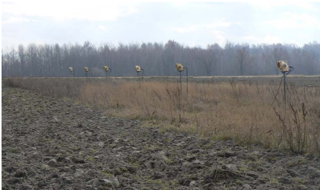
Fot. 23. Budowa elementów i otoczenie systemu świetlnego ŁUCZ-2MU zamontowanego na lotnisku wojskowym
