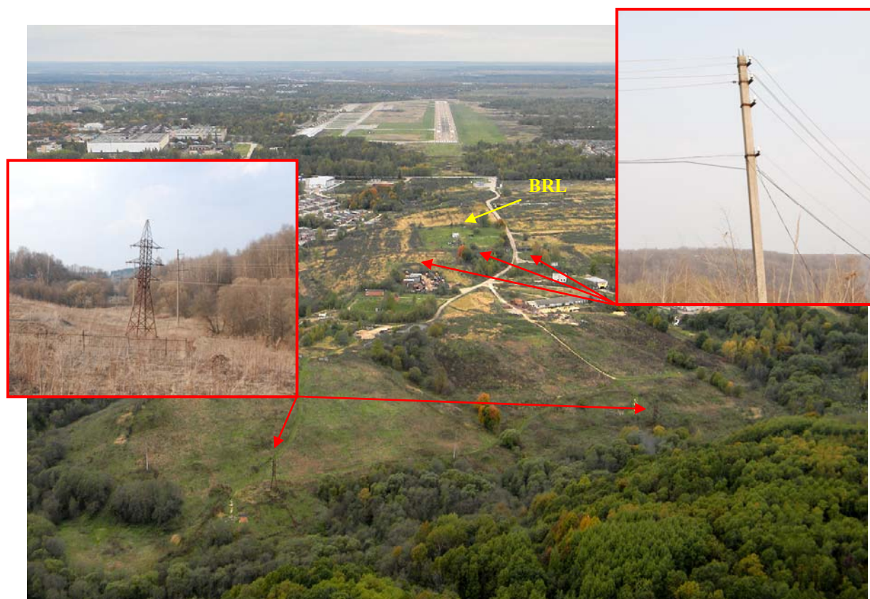
Fot. 17. Lokalizacja linii energetycznych wysokiego i niskiego napięcia w otoczeniu BRL
