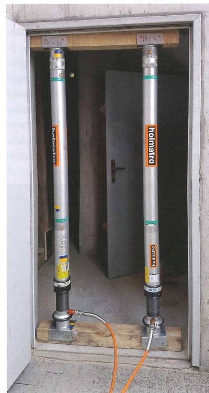
Fot. 2. Stabilizacja otworu drzwiowego. Podciąg i podwalina z drewnianych kantówek, słupy z ratowniczego systemu stabilizacji
