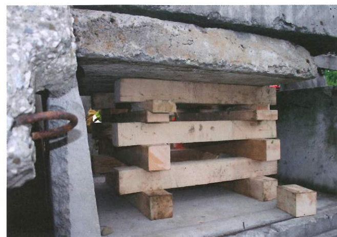
Fot. 3. Stabilizacja otworu drzwiowego podporą bezwoździową układaną w stos 2x2
