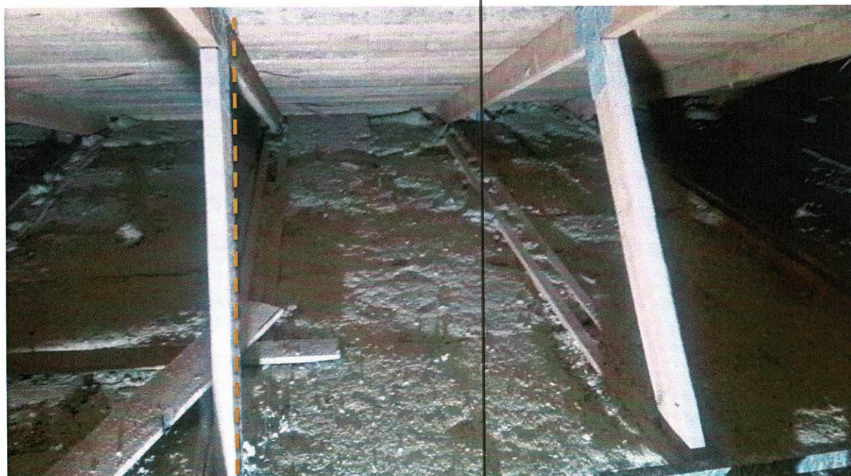
Fot.9: Nadmierne wychylenie pasa górnego z płaszczyzny pionowej
