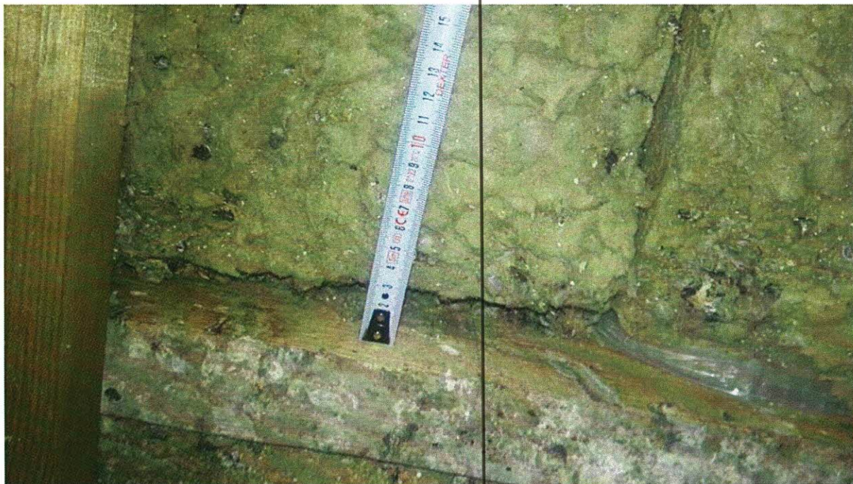
Fot. 11: Luki pomiędzy płytami wełny a konstrukcją pasa dolnego wiażara.
