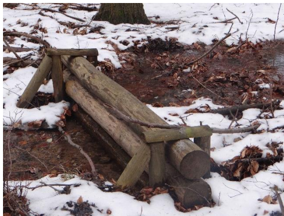
Przykładowy deflektor spowalniający odpływ
