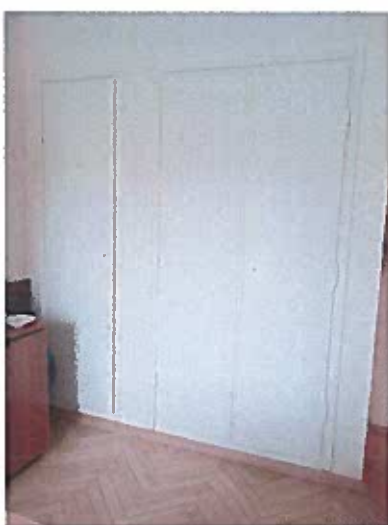
Zdj. Nr 1 Widok Szaf w pokoju biurowym
