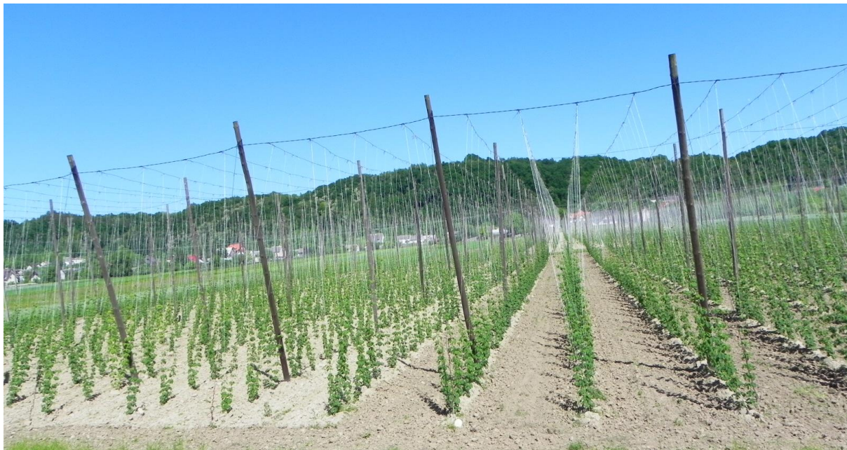
Fot. 1. Konstrukcja wsporcza chmielnika wykonana ze słupów drewnianych impregnowanych olejem kreozotowym w rozstawie 9 \times 9 m.
