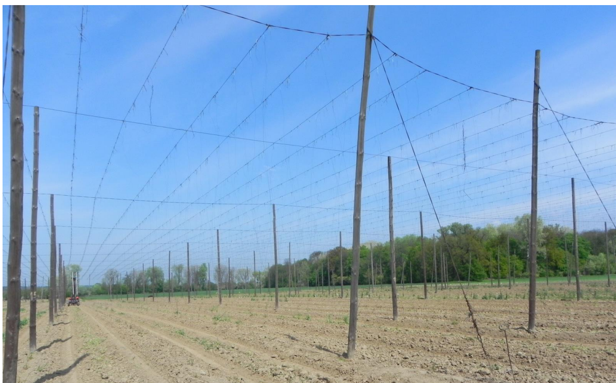
Fot. 2. Konstrukcja wsporcza chmielnika wykonana ze słupów drewnianych impregnowanych olejem kreozotowym w rozstawie 9 \times 12 m.
