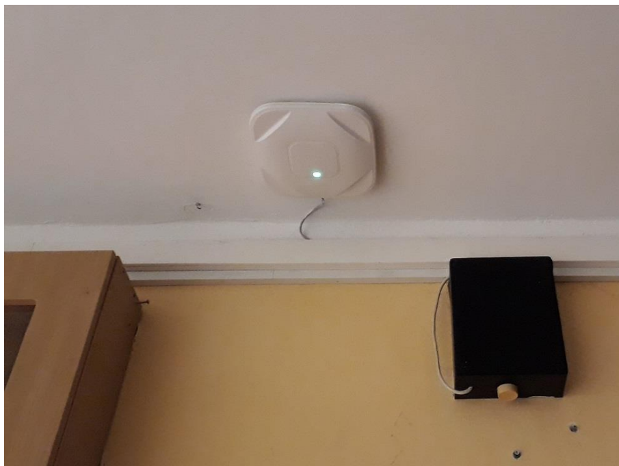
Fot. 1: Zdjęcie punktu dostępowego model AIR-CAP1602I-E-K9
