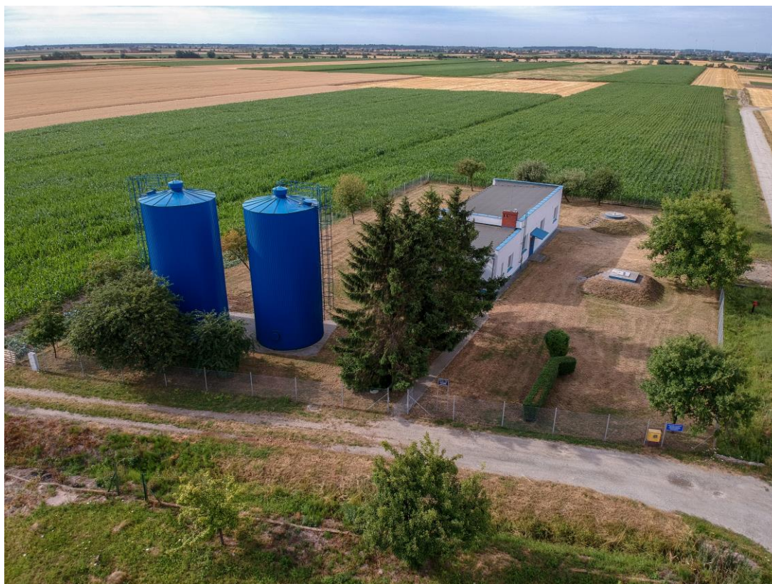
Zdjęcie Nr 2. Stacja Uzdatniania Wody Wymysłowo
