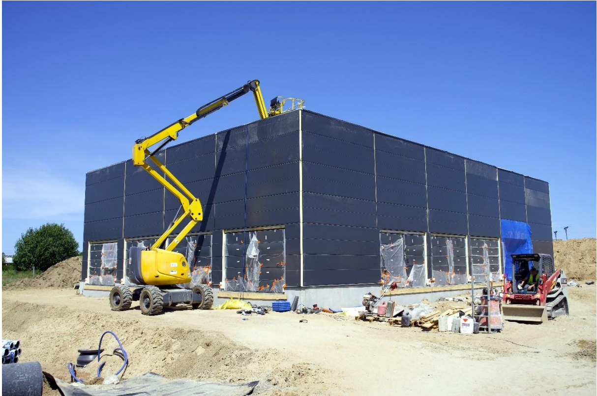
Rysunek 44. Budowa hali. Czerwiec 2023
