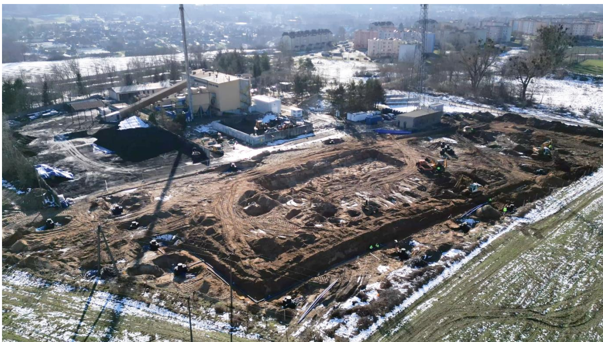
Rysunek 15. Widok na część połączeń poziomych oraz studni rozdzielaczowe gruntowego magazynu ciepła. Luty 2023.
