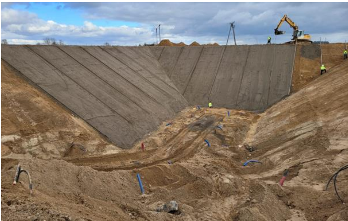
Rysunek 23. Formowanie i utwardzanie boków wodnego magazynu ciepła 15.03.2023.
