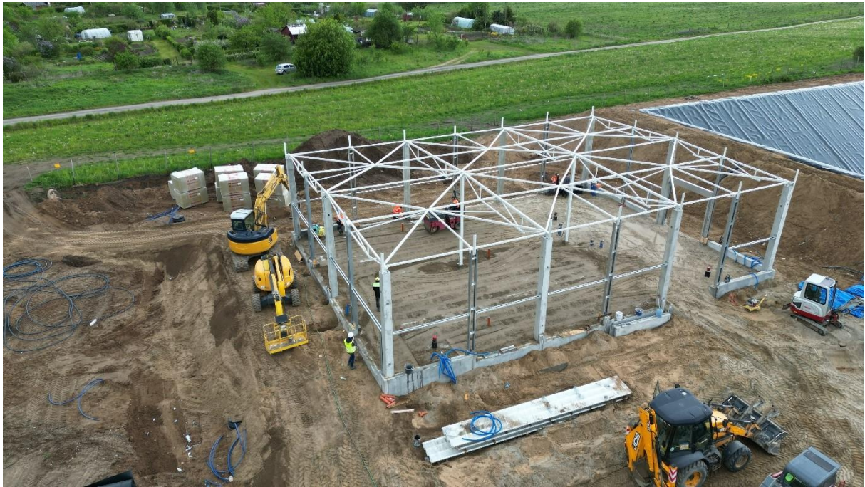
Rysunek 42. Postęp budowy maszynowni. Maj 2023.
