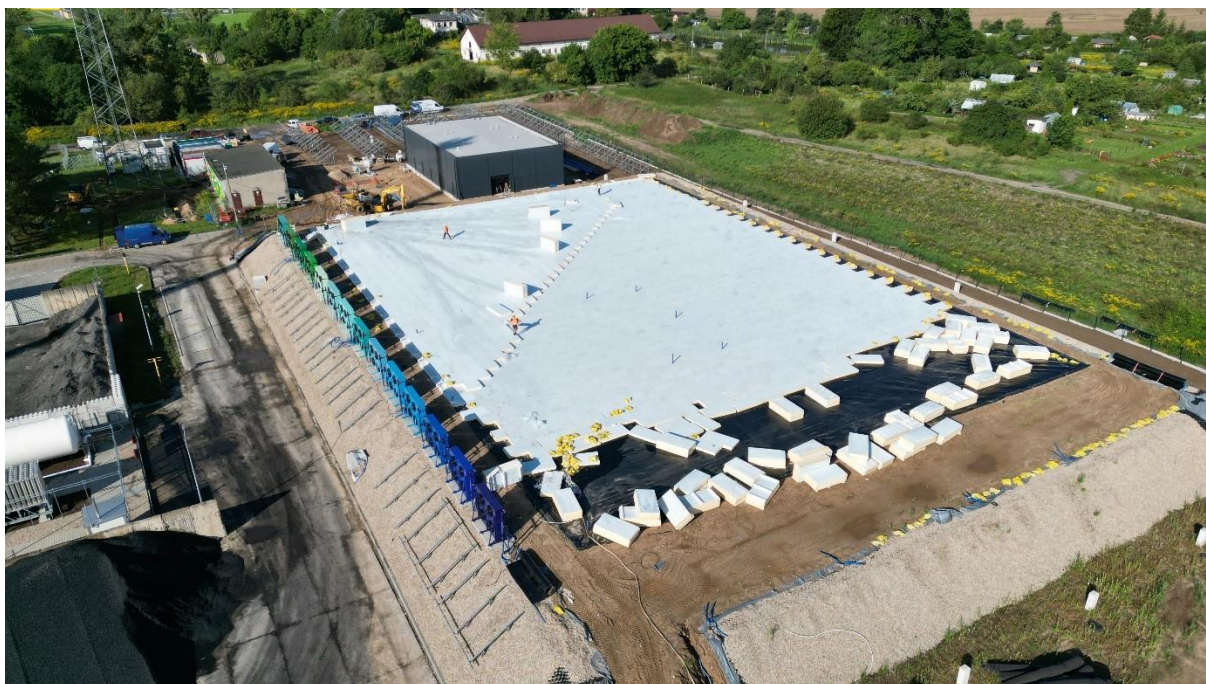
Rysunek 34. Montaż izolacji termicznej na powierzchni basenu.
