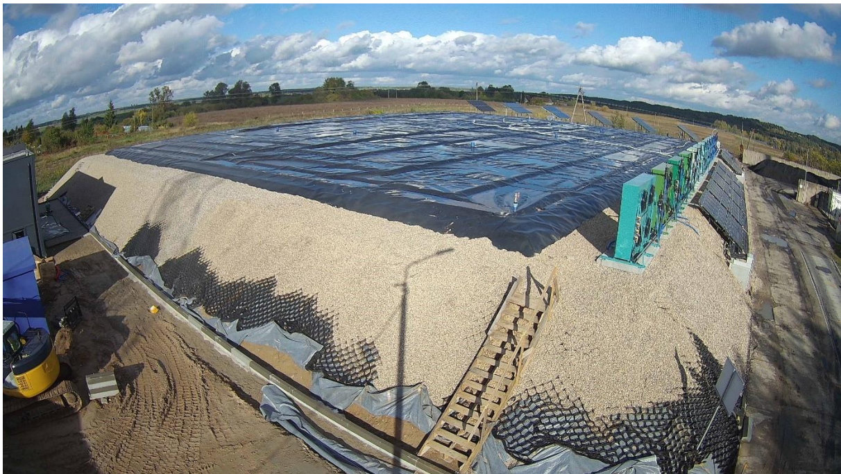
Rysunek 37. Zaizolowany wodny magazyn ciepła PTES. Października 2023
