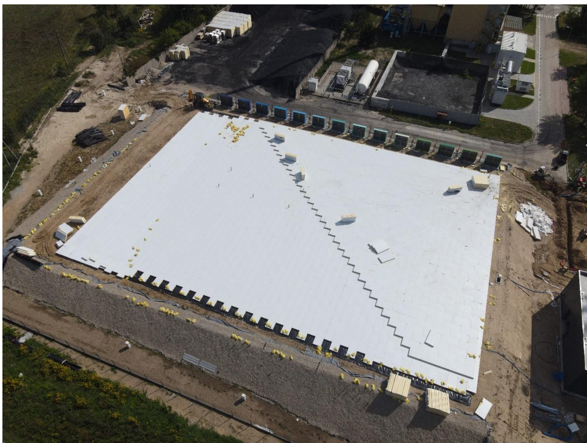
Rysunek 35. Montaż izolacji termicznej na powierzchni basenu.
