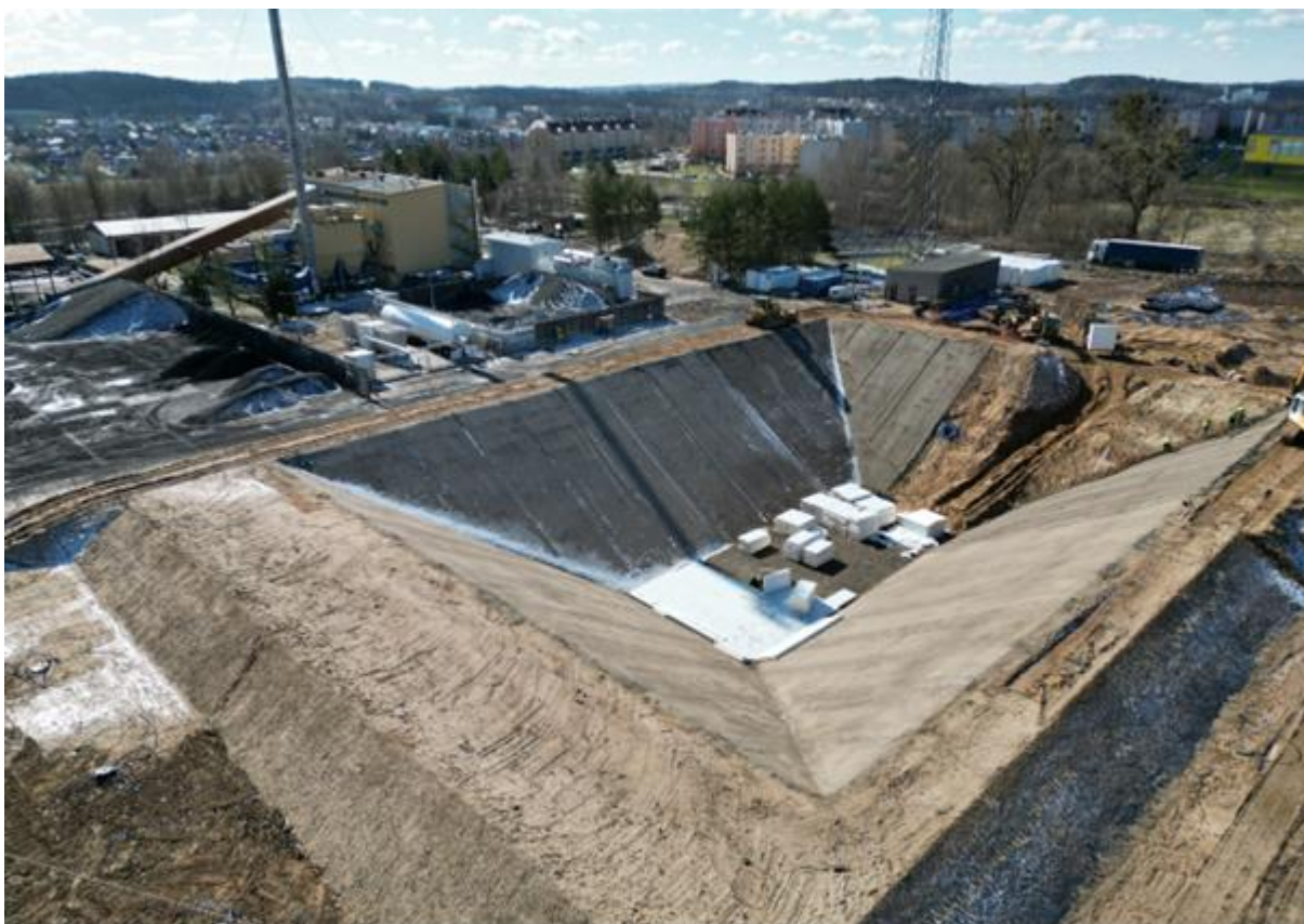
Rysunek 24. Uformowany magazyn PTES, wyrównane i wzmocnione wały. Początek kwietnia 2023.
