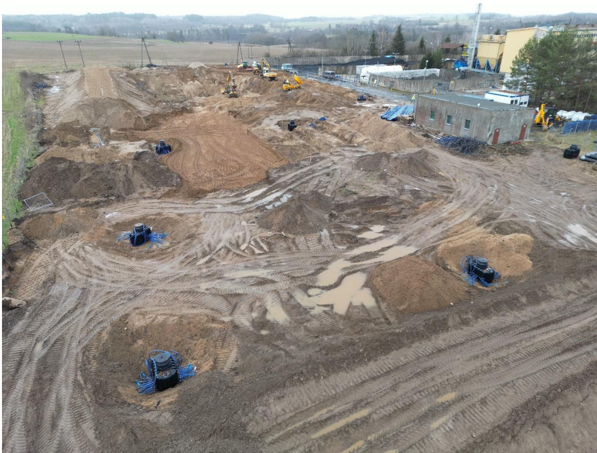
Rysunek 17. Zасыpywane połączenia poziome, widoczne ostatnie studnie rozdzielaczowe przed zakopaniem. Marzec 2023.
