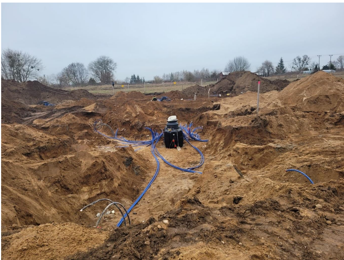
Rysunek 16. Podłączenia poziome gruntowych wymienników ciepła do studni rozdzielaczowej. Marzec 2023.
