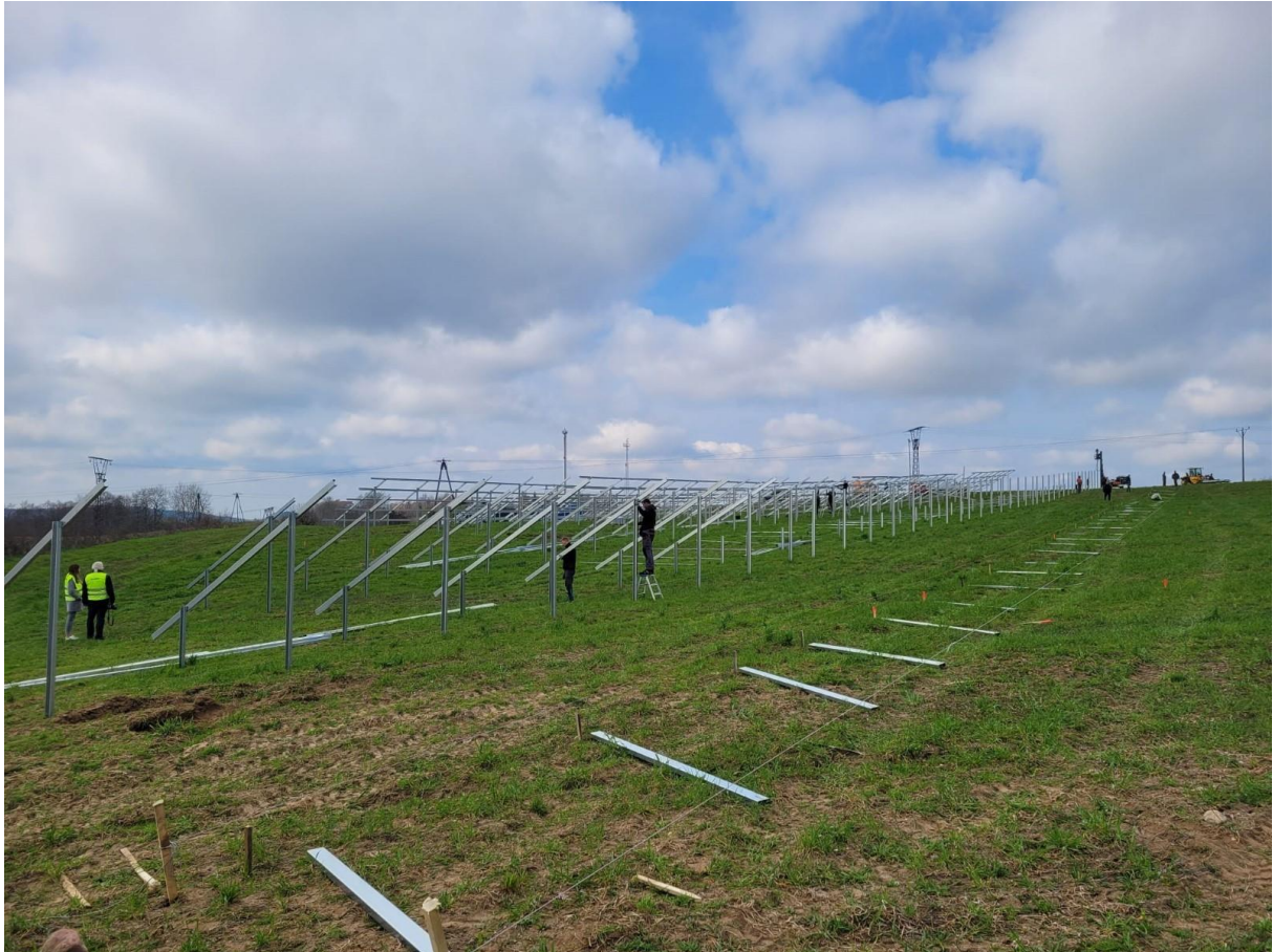
Rysunek 53. Budowa konstrukcji dla farmy PV Koniewo. Kwiecień 2023.
