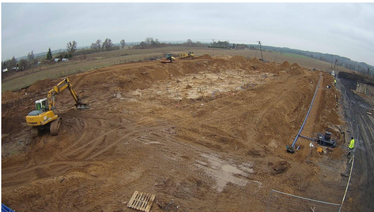
Rysunek 20. Prace ziemne związane z formowaniem niecki basenu. Widać gruntowe wymienniki ciepła zlokalizowane pod basenem. Luty 2023.
