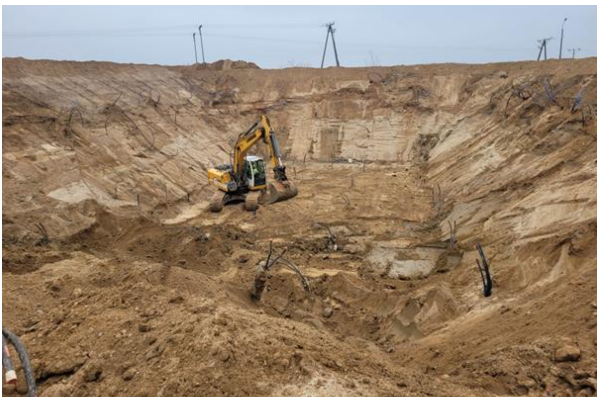
Rysunek 21. Formowanie wodnego magazynu ciepła PTES. Widoczne gruntowe wymienniki ciepła. Początek marca 2023
