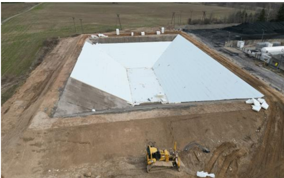
Rysunek 25. Montaż izolacji termicznej wodnego magazynu ciepła. Koniec kwietnia 2023.
