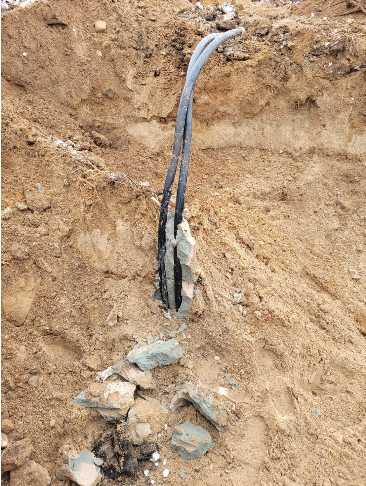
Rysunek 12. Wykonany gruntowy wymiennik ciepła. Widoczne wypełnienie bentonitem - wysokiej jakości betonem termoprzewodzącym.
