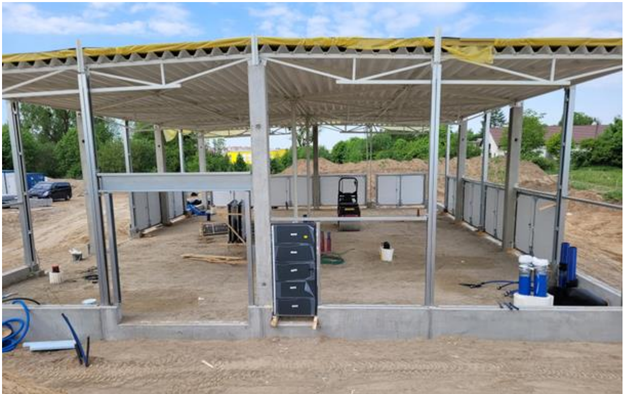
Rysunek 43. Budowa hali. Koniec maja 2023.
