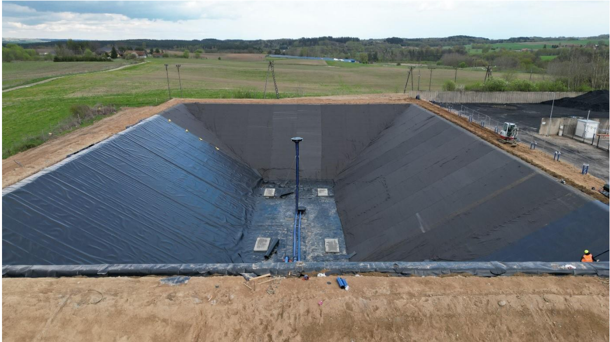
Rysunek 28. Wykładanie wodnego magazynu membraną izolującą. Montaż dyfuzora. Kwiecień 2023.
