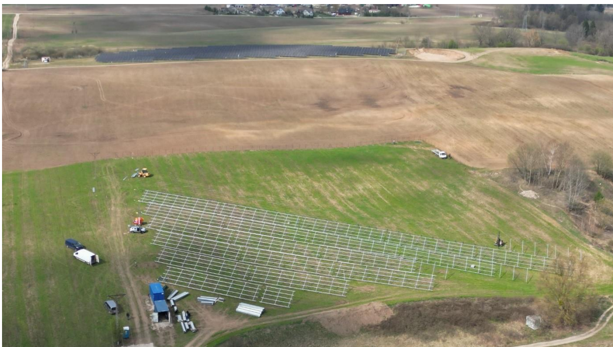
Rysunek 52. Budowa konstrukcji dla farmy PV Koniewo. Kwiecień 2023.
