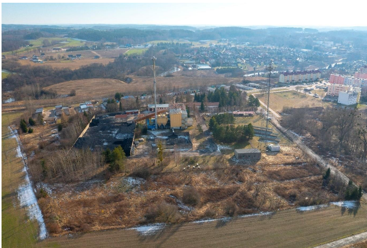
Rysunek 8. Widok na teren inwestycji przed rozpoczęciem prac. Marzec 2022.
