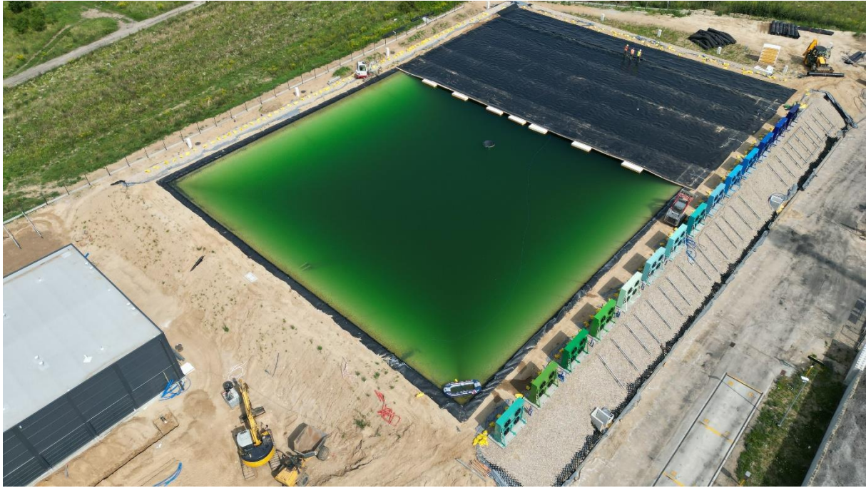
Rysunek 32. Montaż izolacji basenu.
