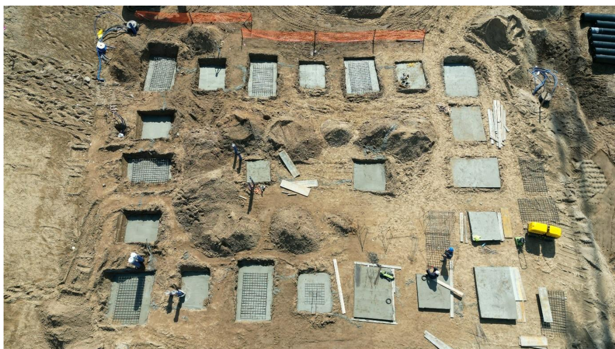
Rysunek 39. Maszynownia pomp ciepła – fundamenty maszynowni. Kwiecień 2023
