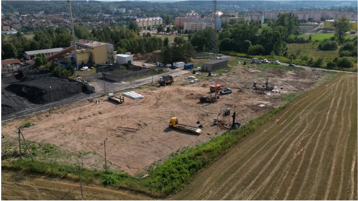
Rysunek 11. Wykonanie odwiertów i montaż pionowych wymienników ciepła. Czerwiec 2023.
