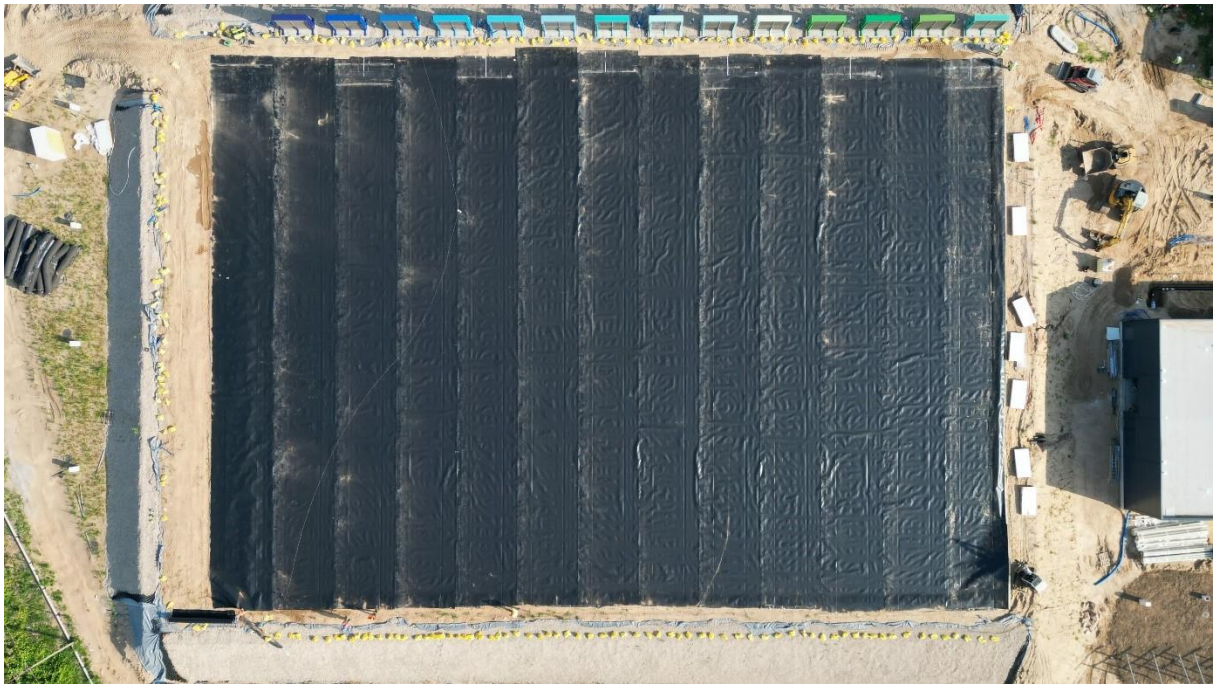
Rysunek 33. Zainstalowana membrana uszczelniająca basen od góry.
