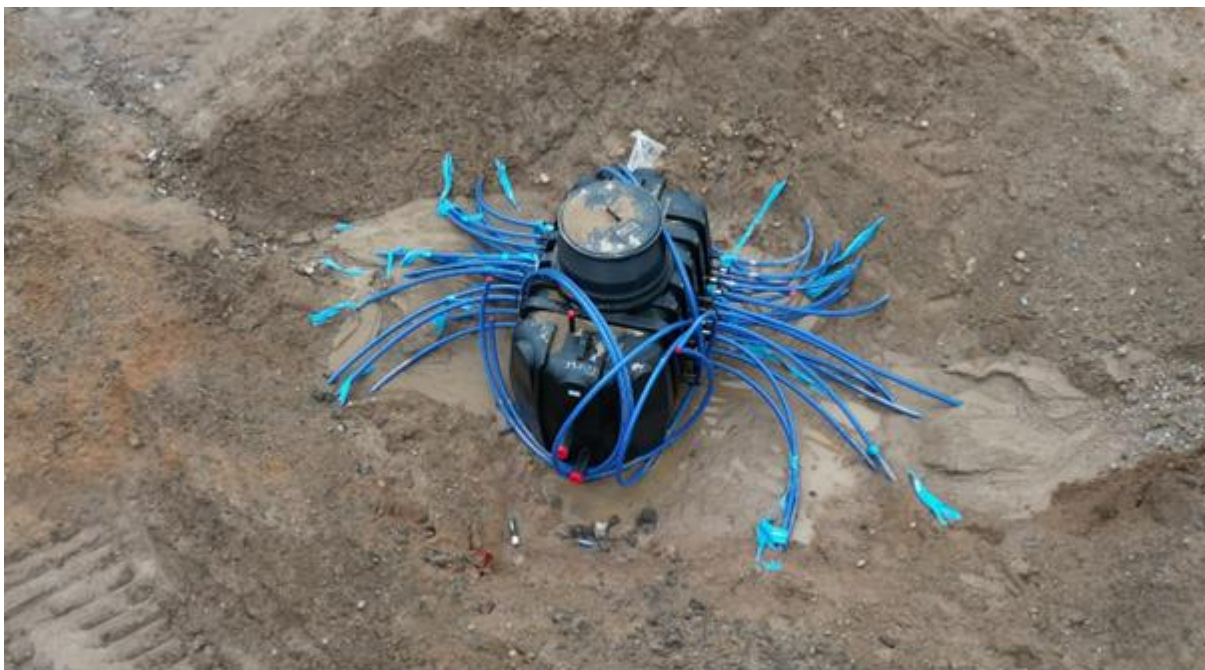
Rysunek 14. Studnia rozdzielacza.
