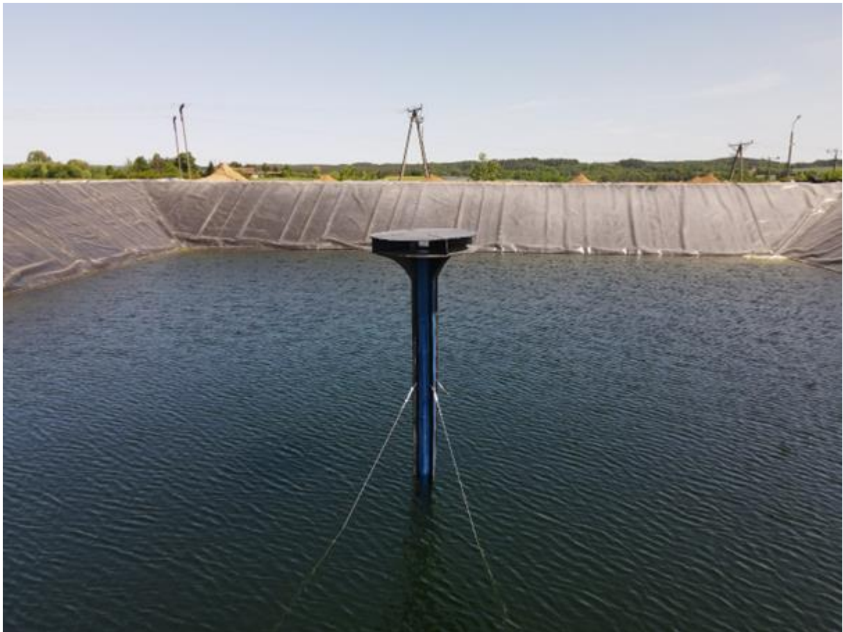
Rysunek 30. Napełnianie basenu, widok na dyfuzor. Koniec maja 2023.
