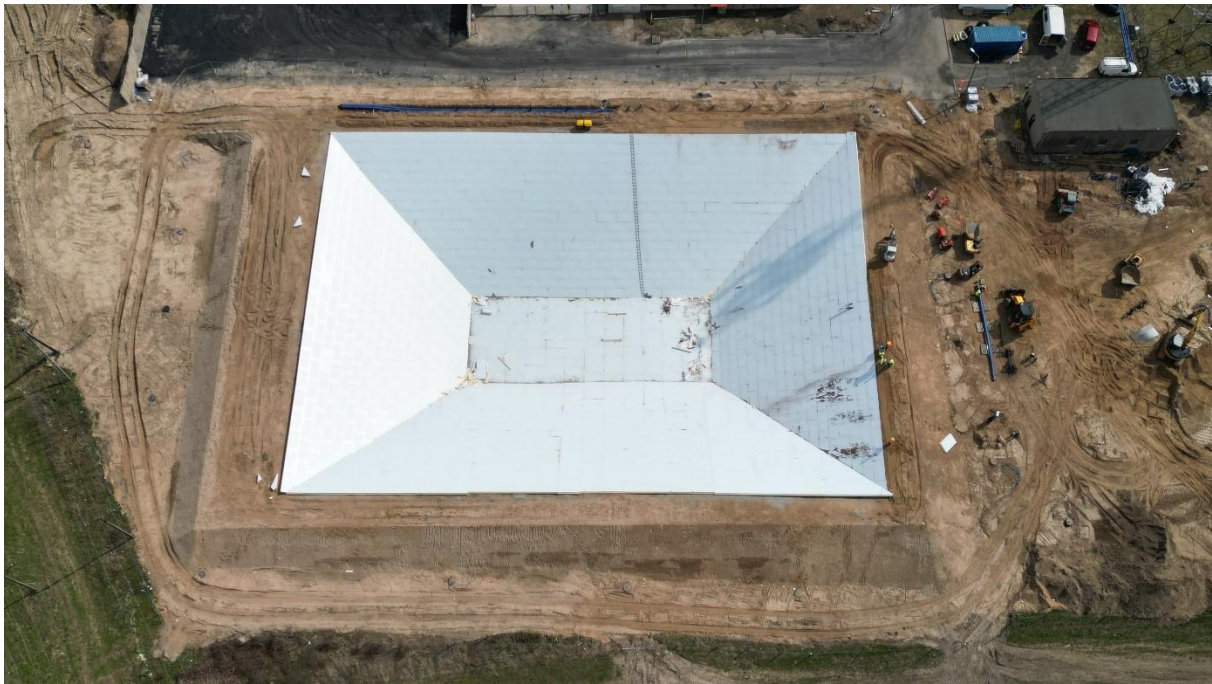
Rysunek 26. Magazyn PTES. Izolacja dna i boków gotowa. Stan na koniec kwietnia 2023.
