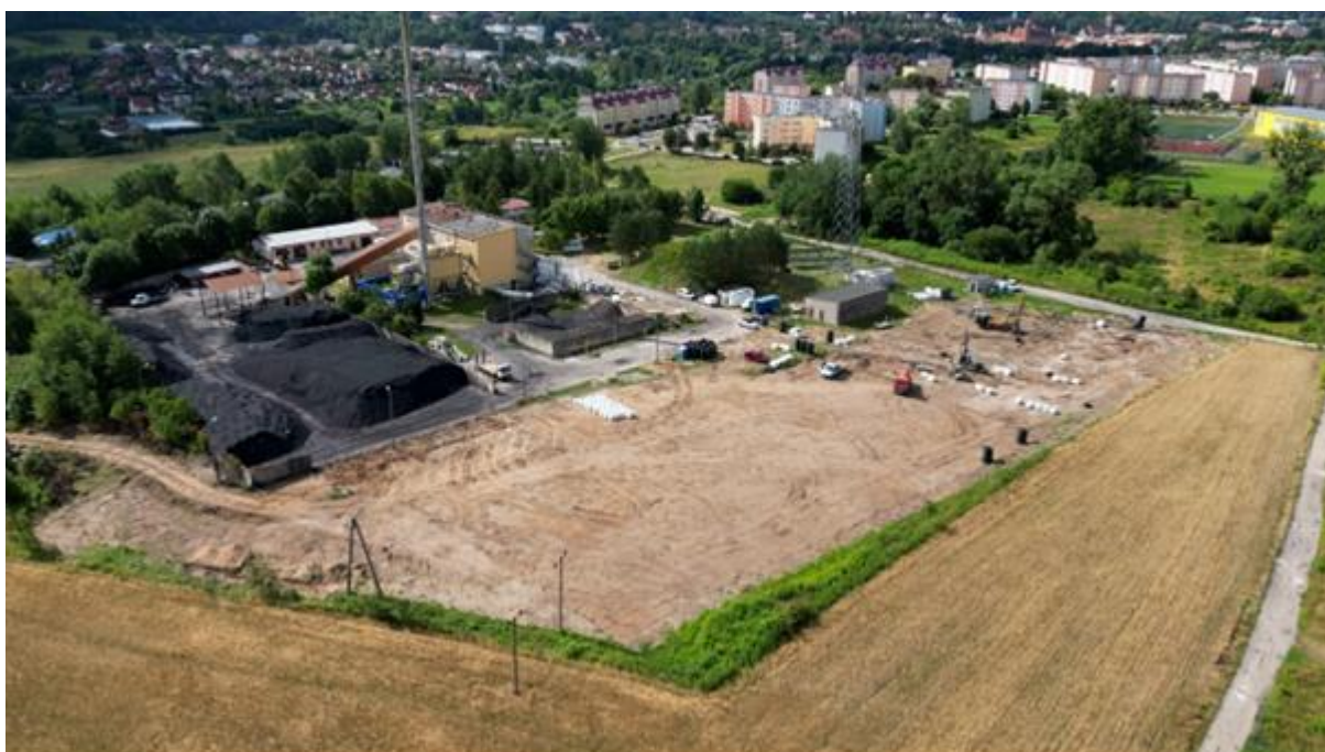
Rysunek 10. Wykonanie odwiertów i montaż gruntowych wymienników ciepła. Czerwiec 2023.
