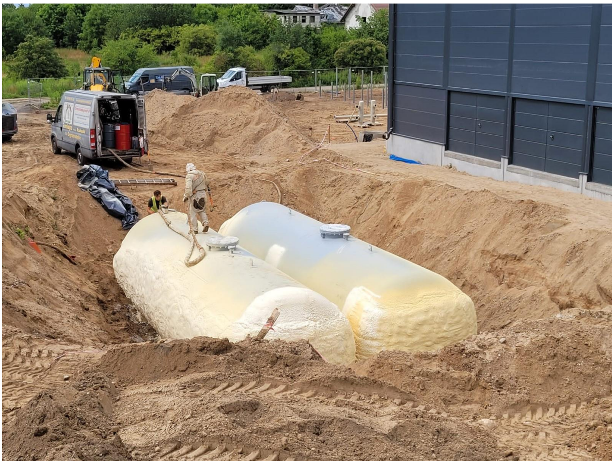
Rysunek 47. Bufor sieci ciepłowniczej - magazyn krótkoterminowy – przed zasypaniem.
