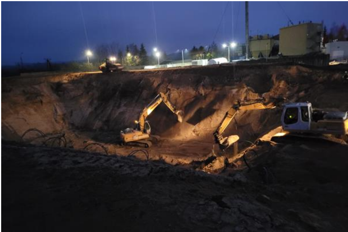
Rysunek 22. Budowa wodnego magazynu ciepła PTES. Prace po zmierzchu. Początek marca 2023.
