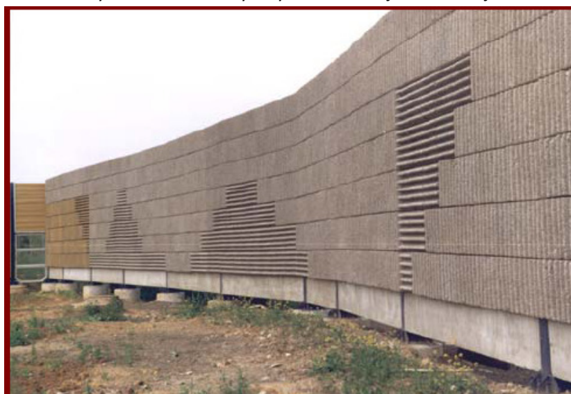
Rys. 2. Ekran akustyczny o konstrukcji betonowej.
