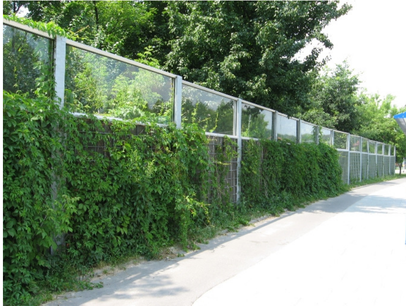
Rys. 18. Przykład nr 3 estetycznego rozwiązania ekranu akustycznego.
