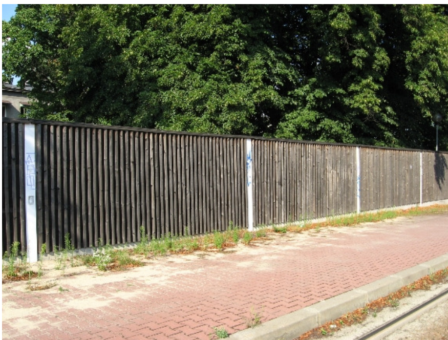
Rys. 3. Ekran akustyczny o konstrukcji drewnianej.
