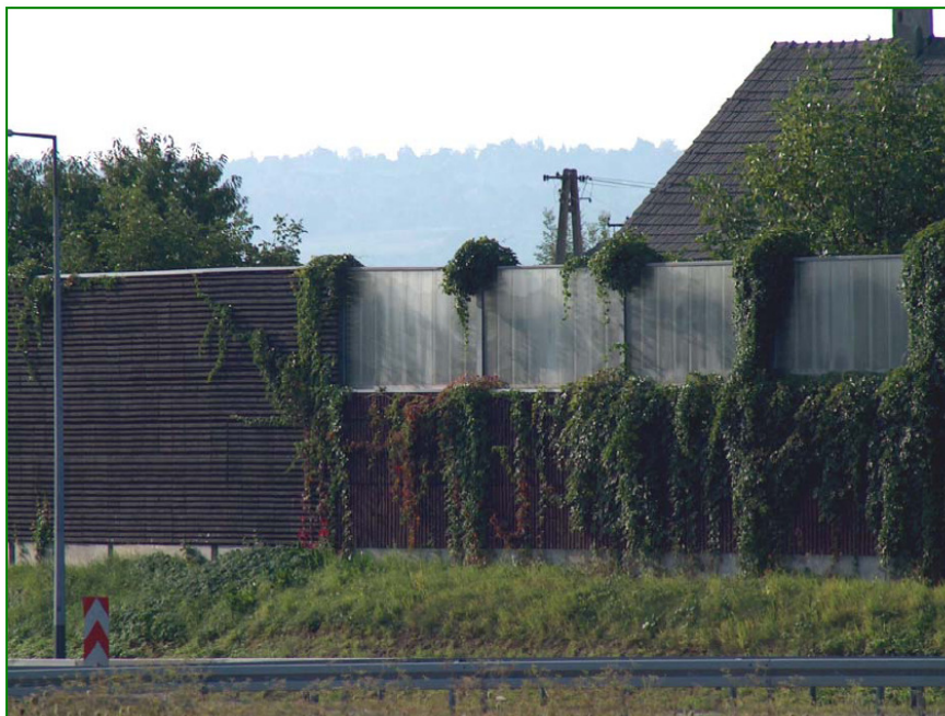
Rys. 1.17. Przykład nr 2 estetycznego rozwiązania ekranu akustycznego.
