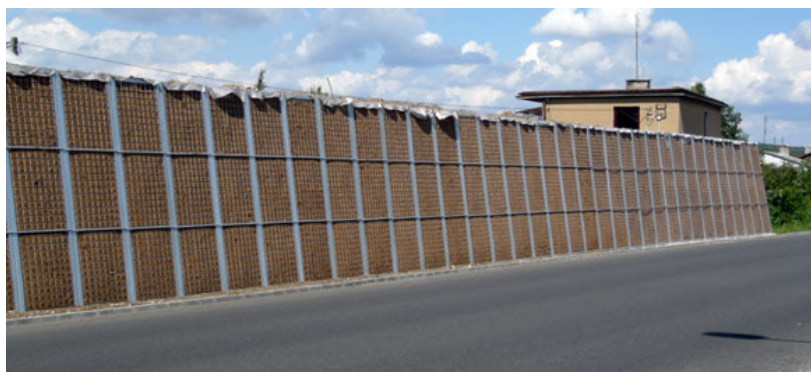
Rys. 25. Pionowa bariera biologiczna - system EMTE GREEN [16]
