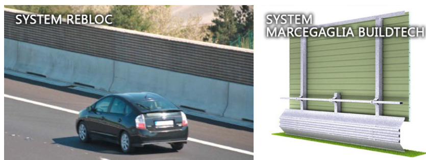
Rys. 27. Bariery akustyczne zintegrowane z barierami ochronnymi: systemy Marcegaglia Buildtech oraz ReBloc [33], [34]
