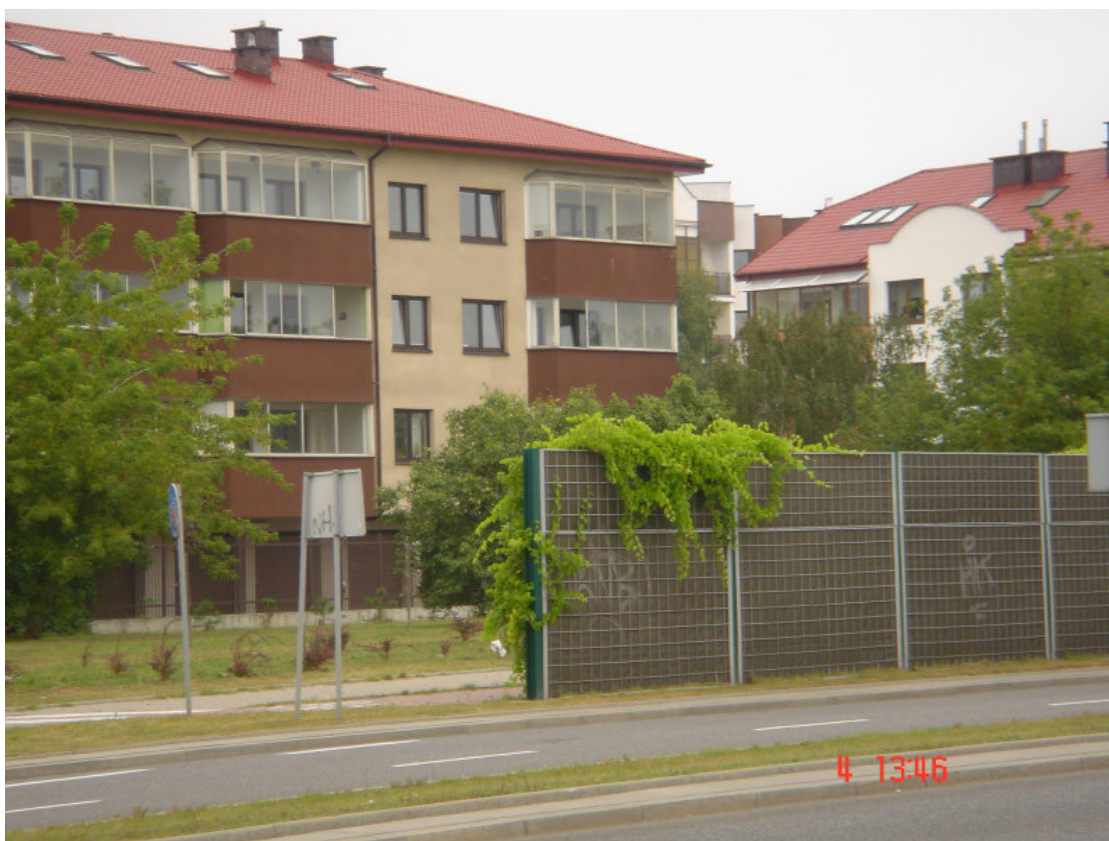
Rys. 13 Przenikanie fali akustycznej przez krawędzie boczne ekranu – rozwiązanie praktyczne
