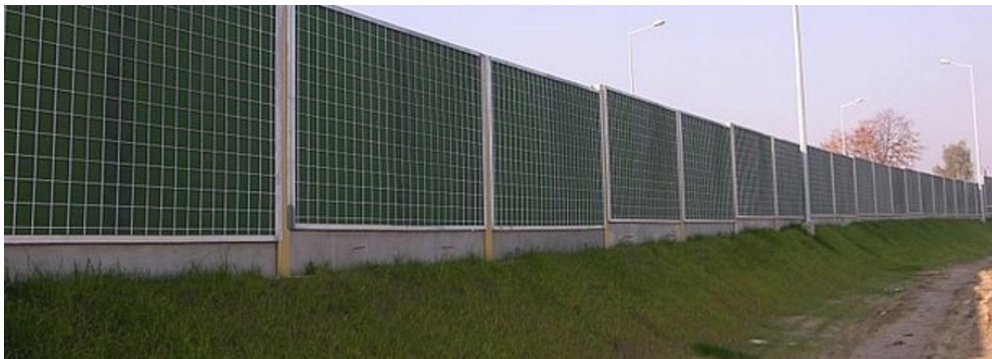
Rys. 26. Ekran akustyczny zielona ściana – system WELDON [29]
