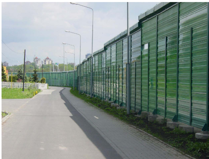
Rys. 1. Ekran akustyczny o konstrukcji metalowej.
