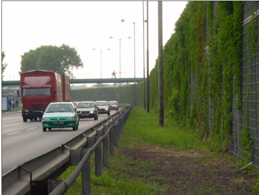
Rys. 16. Przykład nr 1 estetycznego rozwiązania ekranu akustycznego.
