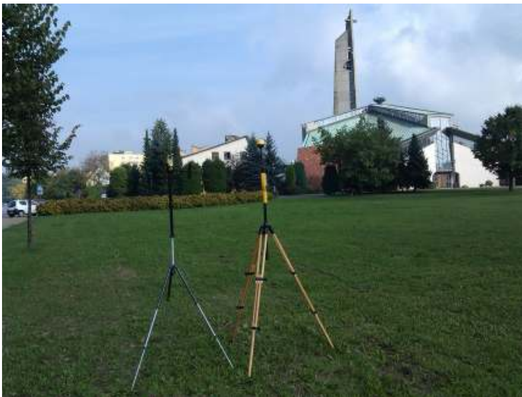
Fot. 1. Rejon badań, widok w kierunku północno-wschodnim
